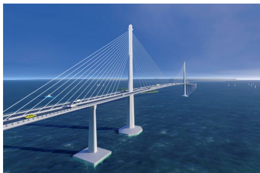
Figura 8. Vista del puente
