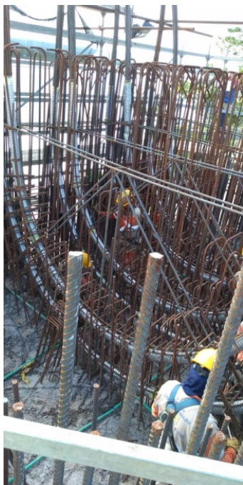
Figura 22. Pretensado vertical en empotramiento provisional
