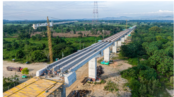
Figura 7. Vista del tramo de vigas
