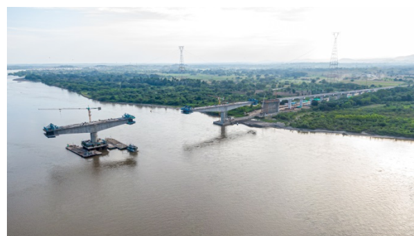
Figura 11. Vista de tramo P19 y P20 y tramo de acceso
