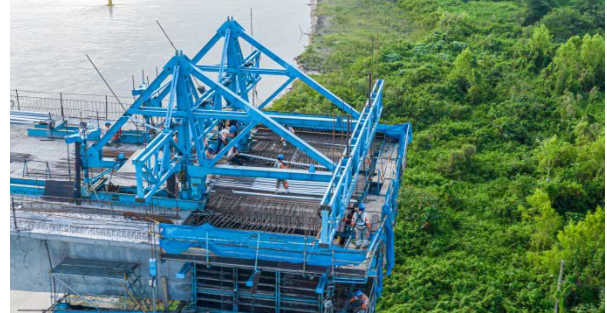
Figura 18. Carro de avance vista lateral
