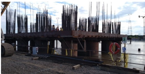
Figura 16. Prelosas para encofrado de encepados de pila P20 en el río
