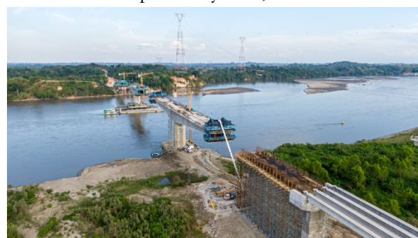
Figura 12. Vista aérea del puente principal y cimbra calado máximo. La anchura total del tablero es de 12.95 m. Los vanos principales tienen una variación de canto parabólica entre 10.0 m en la sección de apoyos y 3.0 m en la sección de centro de vano.
