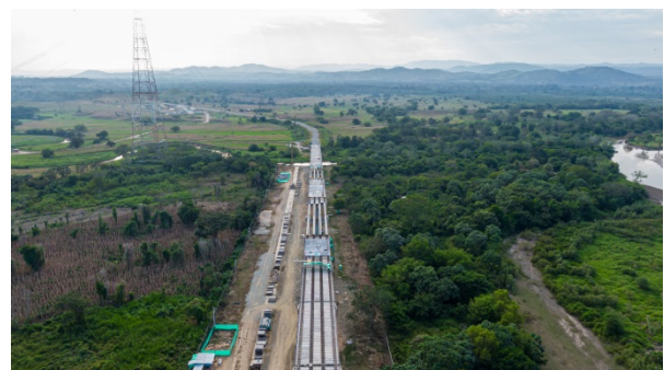
Figura 8. Vista aérea del tramo de vigas
