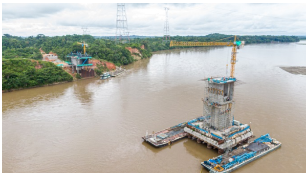
Figura 21. Construcción de dovela 0 de P20 en el río
