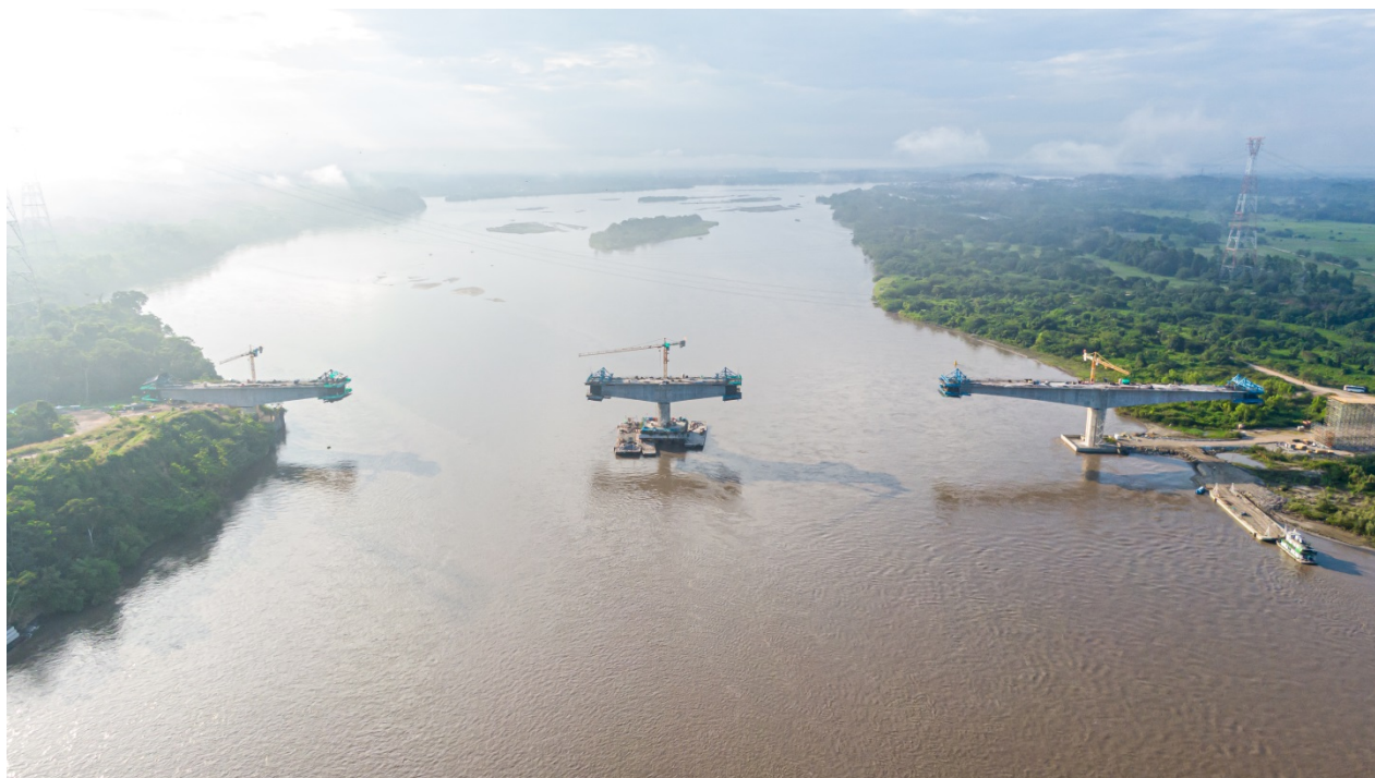
Figura 23. Vista general del tramo principal en construcción
