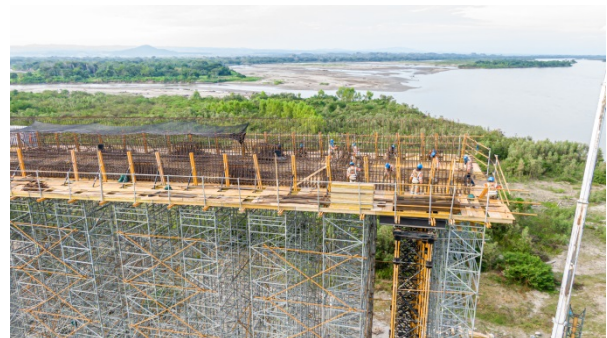
Figura 20. Detalle de zona cimbrada de P17
