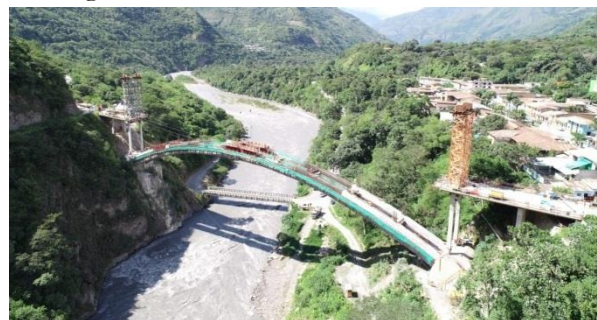
Figura 9. Arco en fase intermedia de hormigonado
