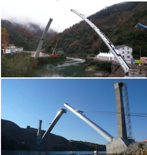
Figura 2 Abatimientos de los puentes de Endarlatsa (2008) y del viaducto del TAV sobre el río Tera. (2013) Proyecto CFC
