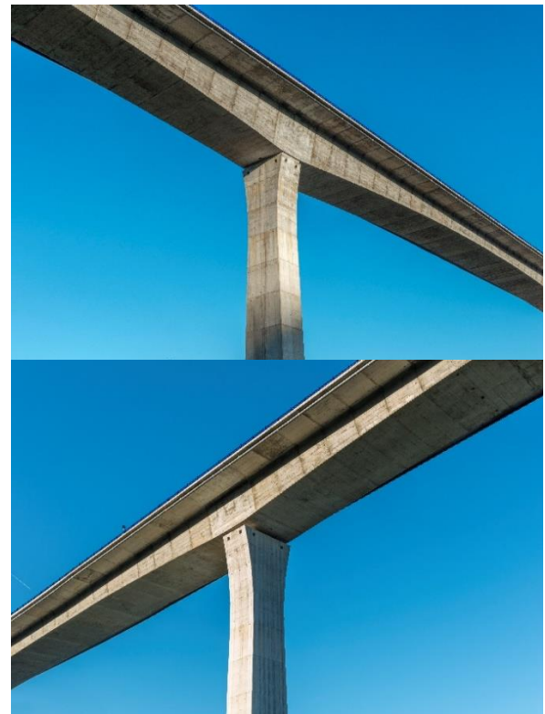
Figura 7 Configuración de apoyos sobre pilas: mismo diseño para pilas empotradas y apoyadas
