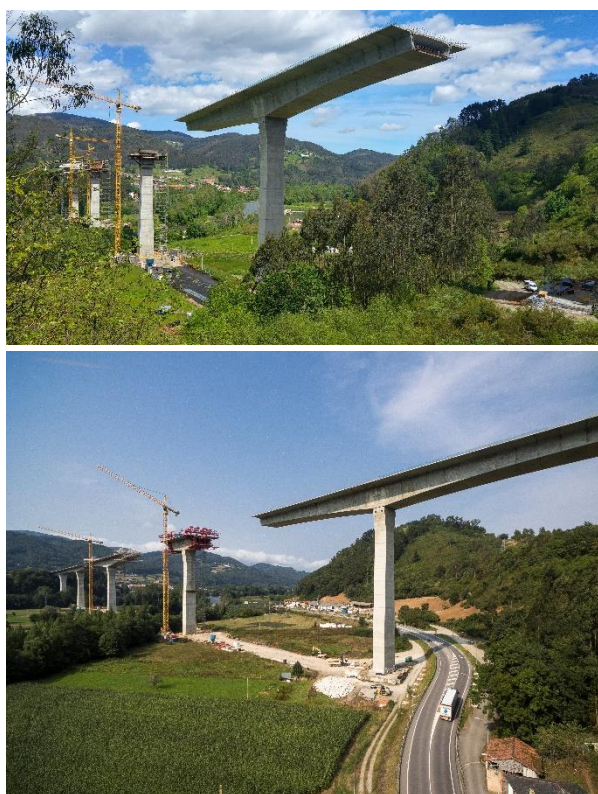
Figura 9 Construcción por avance en voladizos
