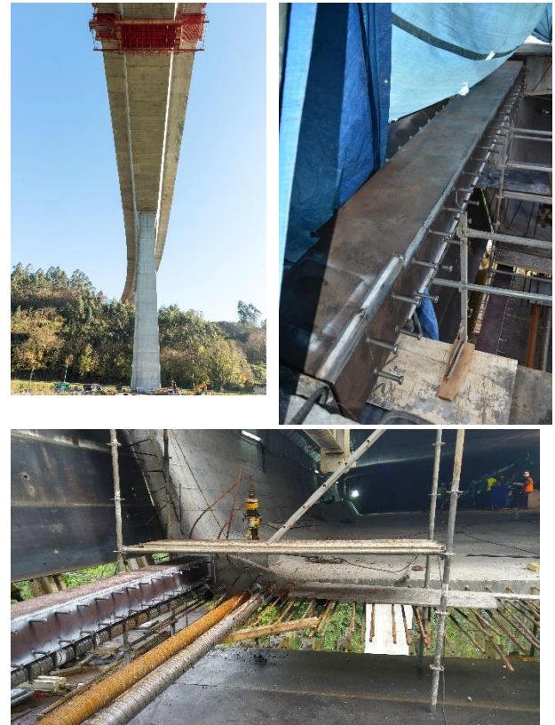
Figura 12 Bloqueo y hormigonado de las dovelas centrales, con el encofrado del carro, 4 vigas embebidas en cada esquina y pretensado sólo inferior para comprimir toda la sección durante la operación
