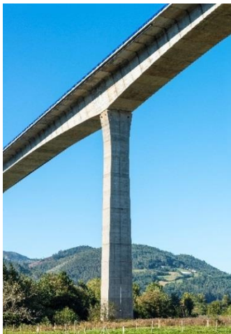
Figura 6 Diseño característico de Carlos Fernández Casado, SL para las pilas. Canto constante longitudinal, canto variable transversal
