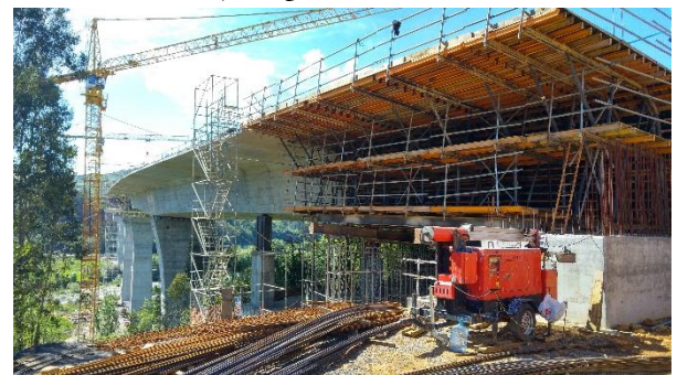
Figura 13 Ejecución de los vanos extremos con pilas provisionales y cimbra cuajada.
