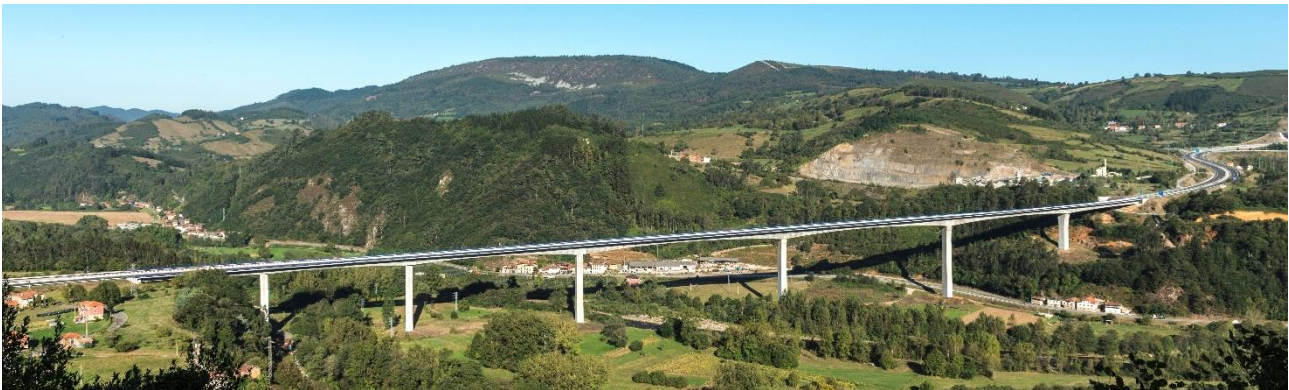
Figura 15 Fotografía del puente acabado
