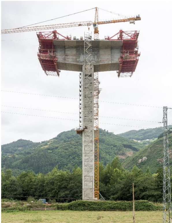
Figura 11 Ejecución de la primera dovela de 2x5.0 m, montaje de los carros de avance y ejecución siguientes dovelas
