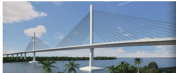
Fig. Vista del tramo atirantado.
