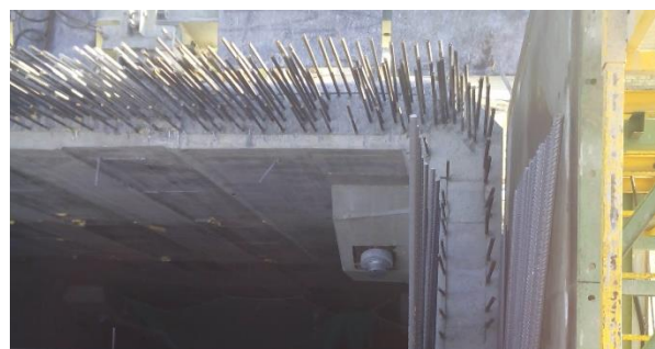
Figura 8. Anclaje pasivo en arco
