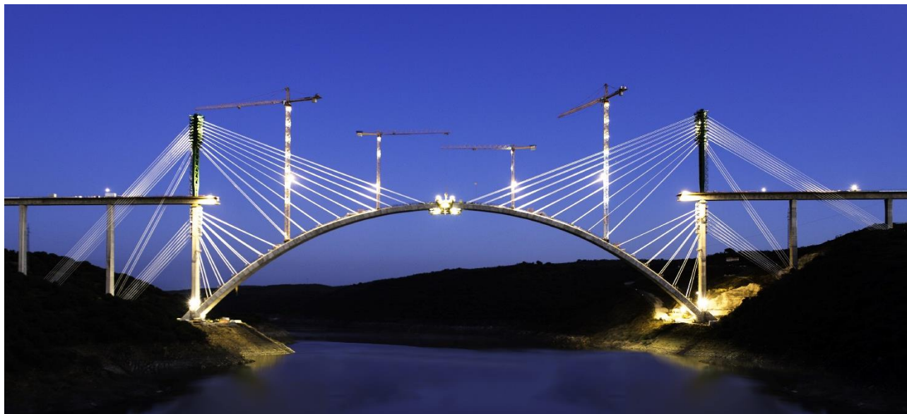
Figura 7. Proceso constructivo del arco (imagen de obra)
