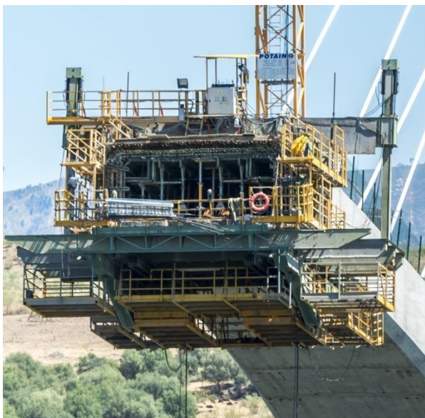
Figura 6. Carro de hormigonado del arco
