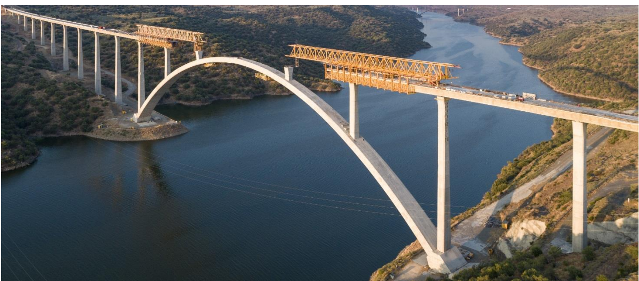
Figura 12. Ejecución de talero sobre arco
