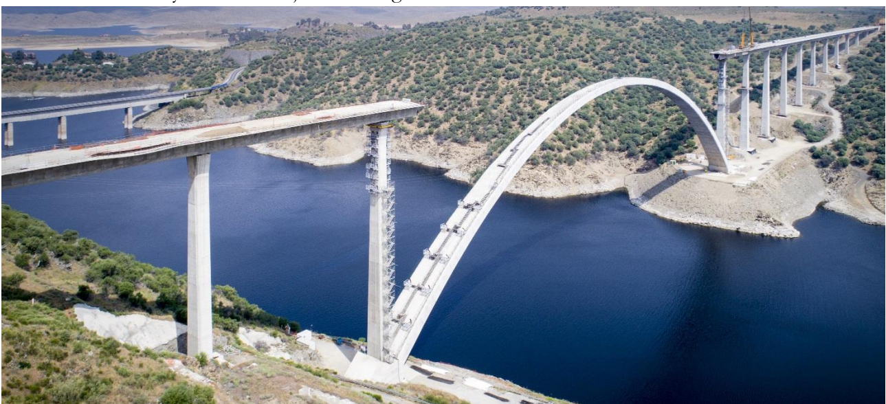
Figura 11. Final de ejecución de arco
