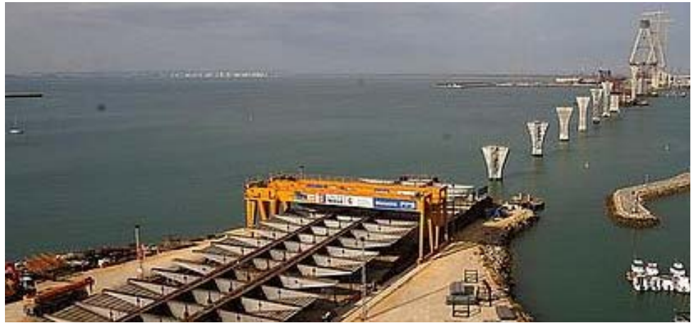
figura 14. Otras vistas del proceso de empuje del tablero del viaducto lado acceso Cádiz
