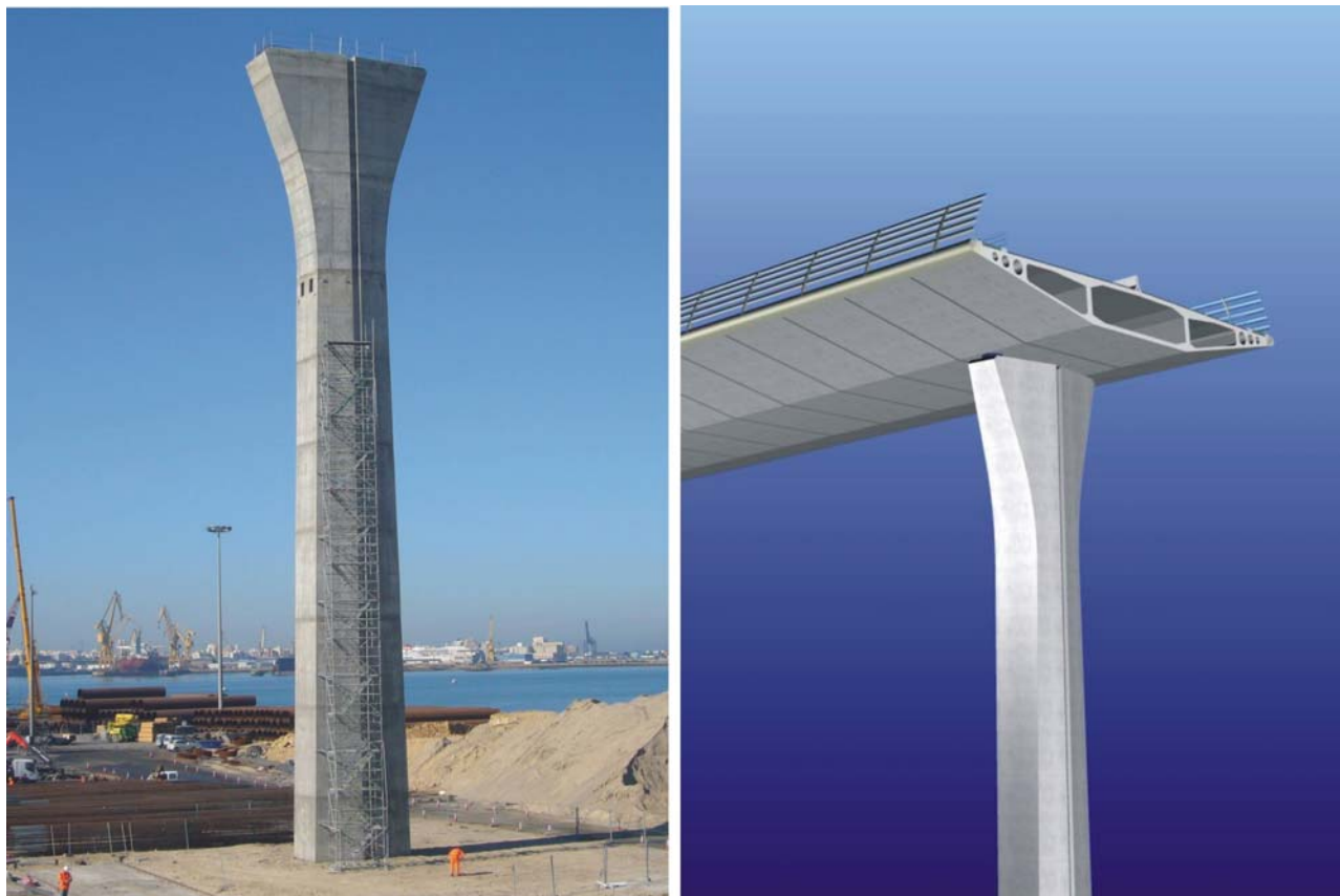
figura 29. Vista del viaducto de acceso lado Puerto Real, canto 3.00 m
