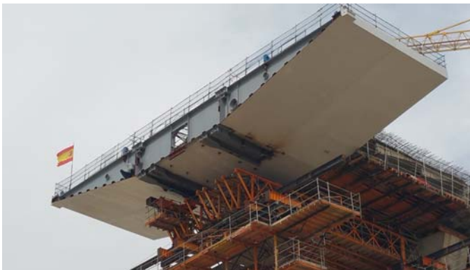
figura 34.Dovela de conexión dintel mixto – dintel hormigón
