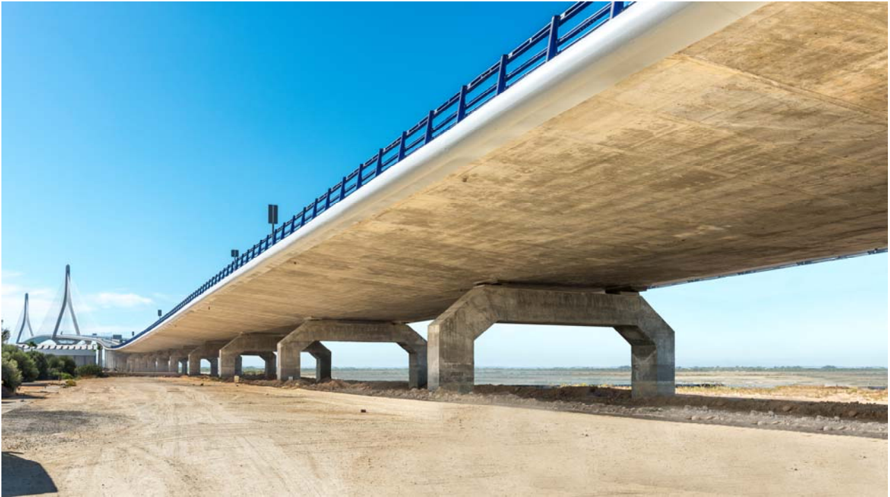
figura 32. Vista del viaducto de acceso lado Puerto Real, canto 2.00 m
