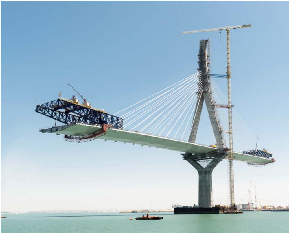
figura 26. Construcción por avance en voladizo simétrico
