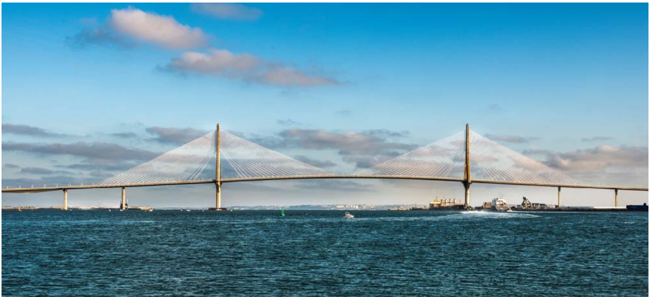
figura 36. Vista lateral final del puente atirantado
