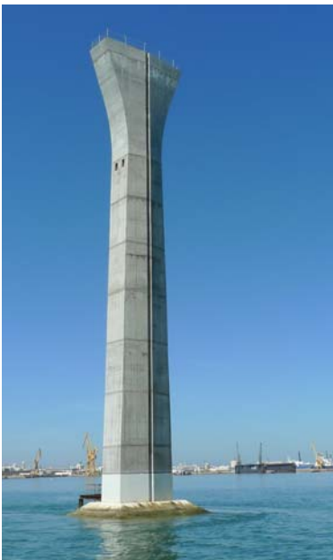
figura 15. Fuste de las pilas
