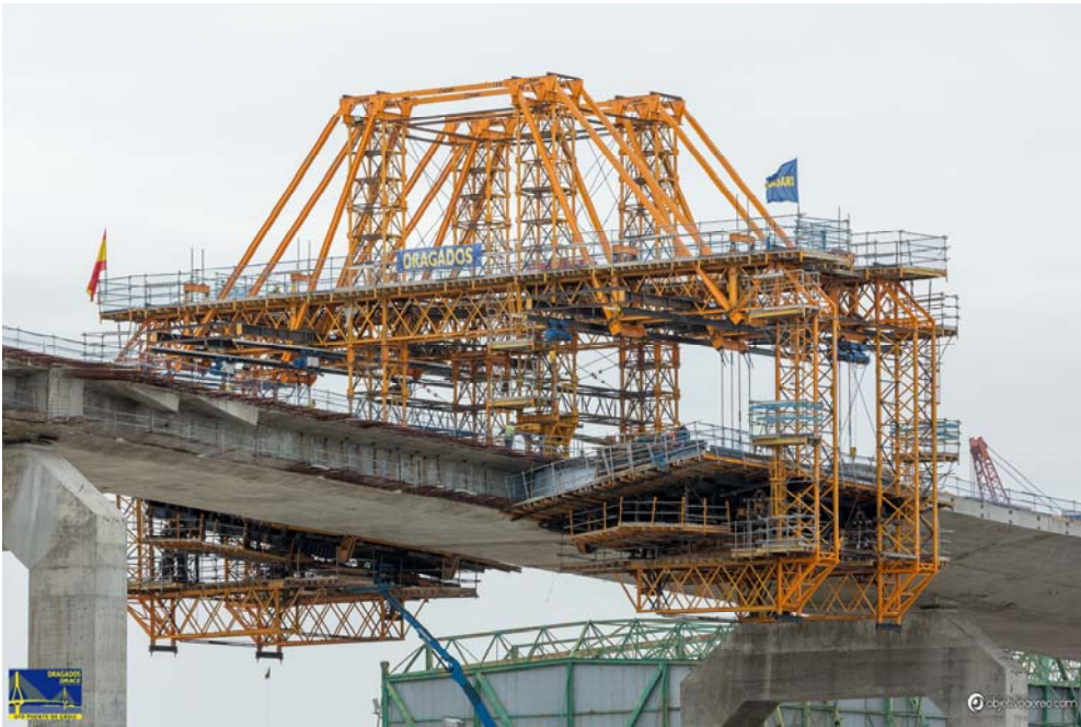
figura 33.(a, b) Construcción del viaducto de acceso lado Puerto Real
