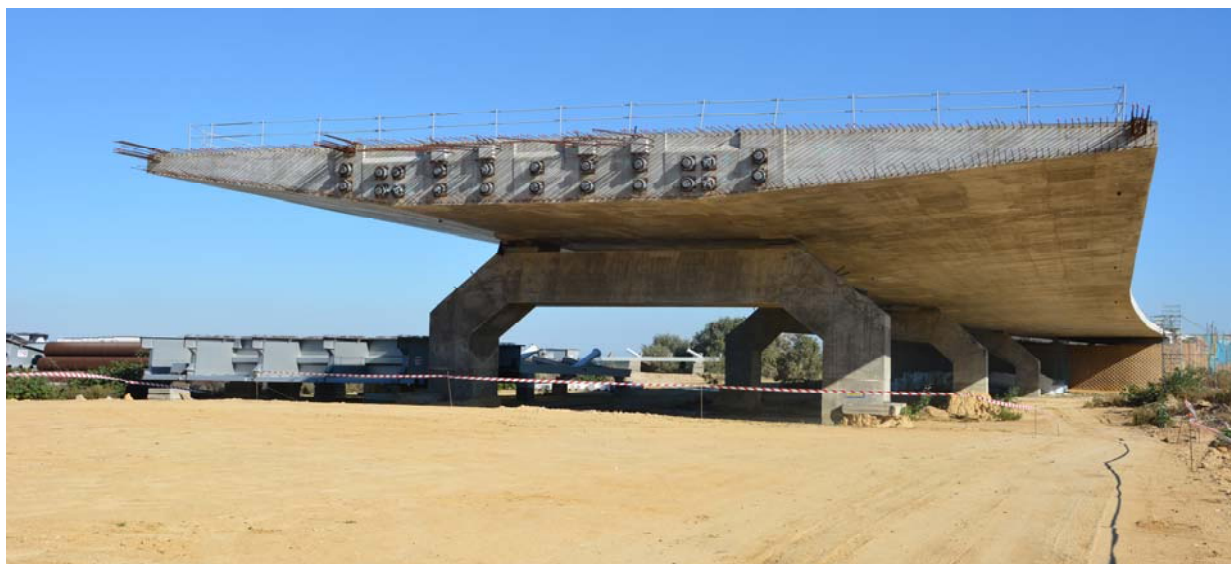
figura 31. Evolución de las secciones tipo en el Viaducto de Acceso Lado Puertorreal
