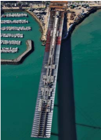
figura 14. Otras vistas del proceso de empuje del tablero del viaducto lado acceso Cádiz
