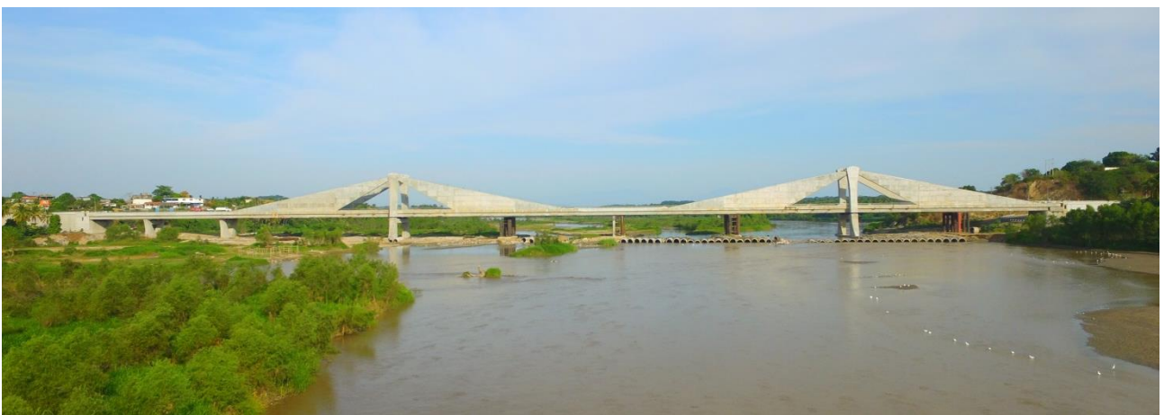
Figura 13. El puente terminado antes de retirar los apoyos provisionales
