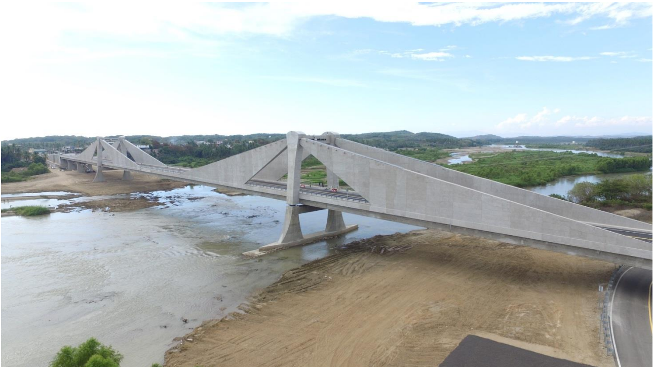
Figura 1. Vista general del puente
