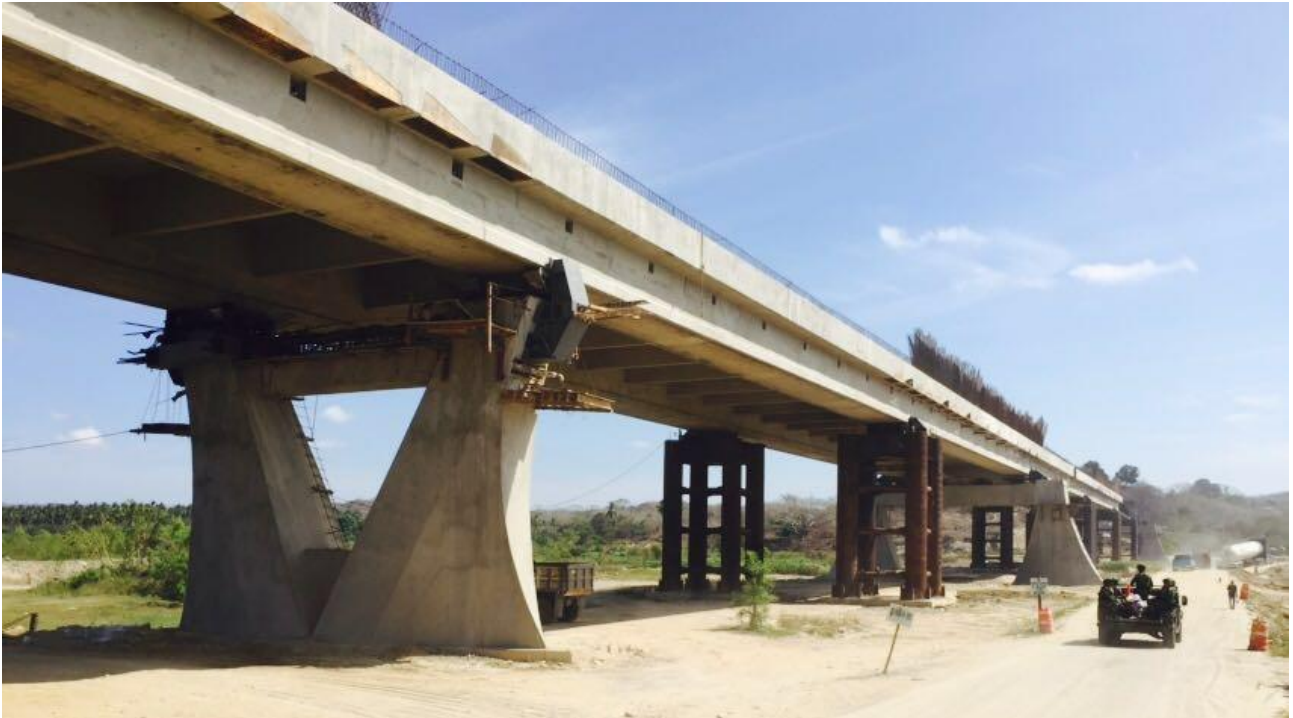
Figura 12. Los topes transversales en las pilas durante el empuje
