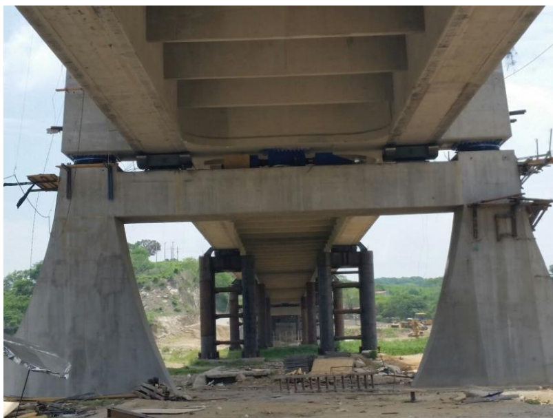
Figura 4. Aisladores sísmicos longitudinales en estribo 1 y transversales bajo una de las torres. Bajo el tablero se ven los apoyos definitivos, los balancines para el empuje y el amortiguador transversal
