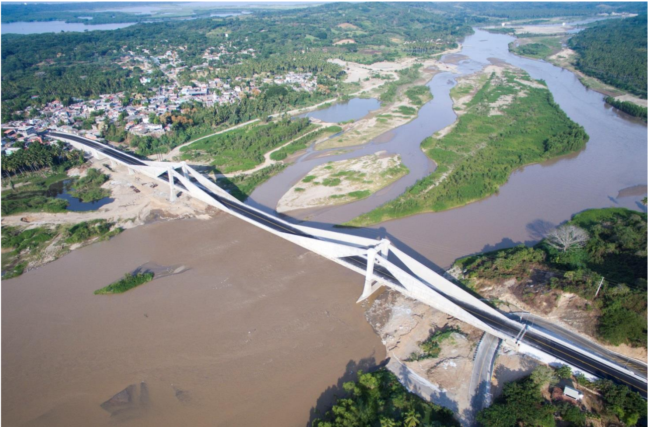
Figura 14. Vista aerea del puente terminado.
