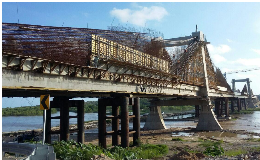
Figura 9. Las velas durante la construcción.
