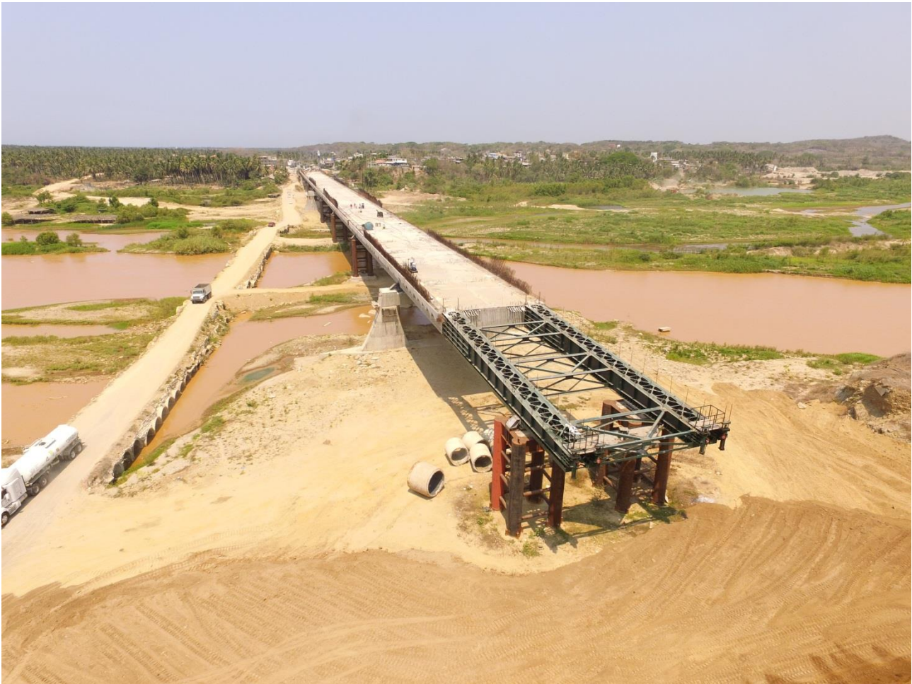
Figura 3. El tablero durante el empuje
