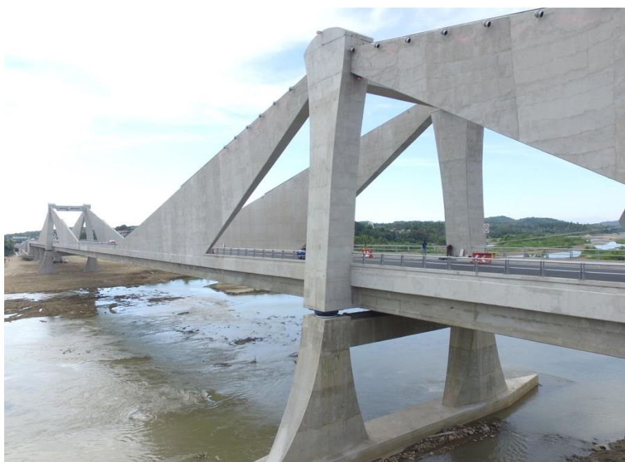
Figura 7. Torres de atirantamiento
