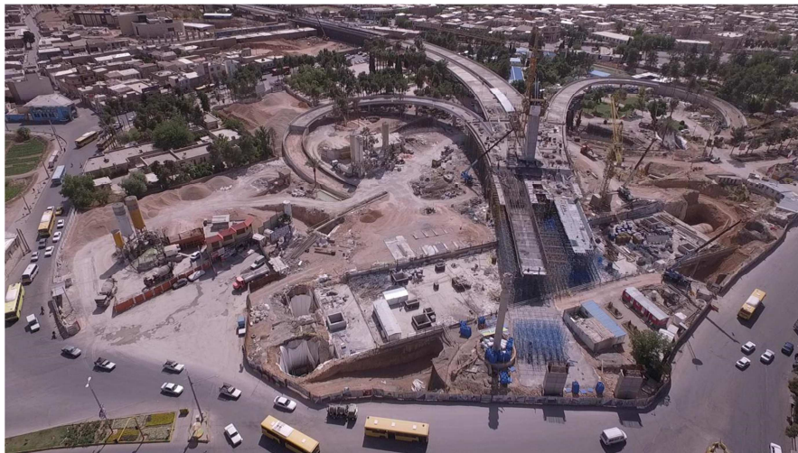
Figura 19. Foto del puente durante la construcción
