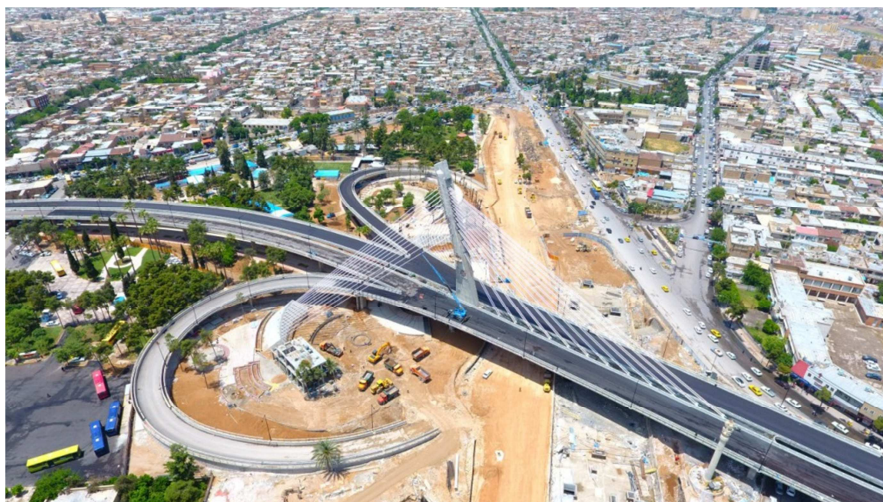
Figura 20. Foto del puente terminado
