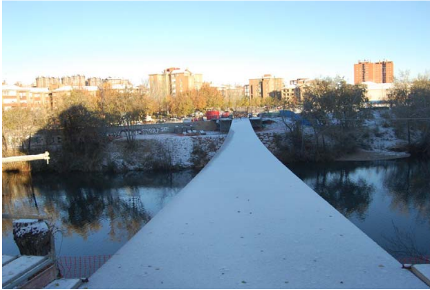
Figura 4. Vista de la pletina antes de colocar losas en un día nevado.
