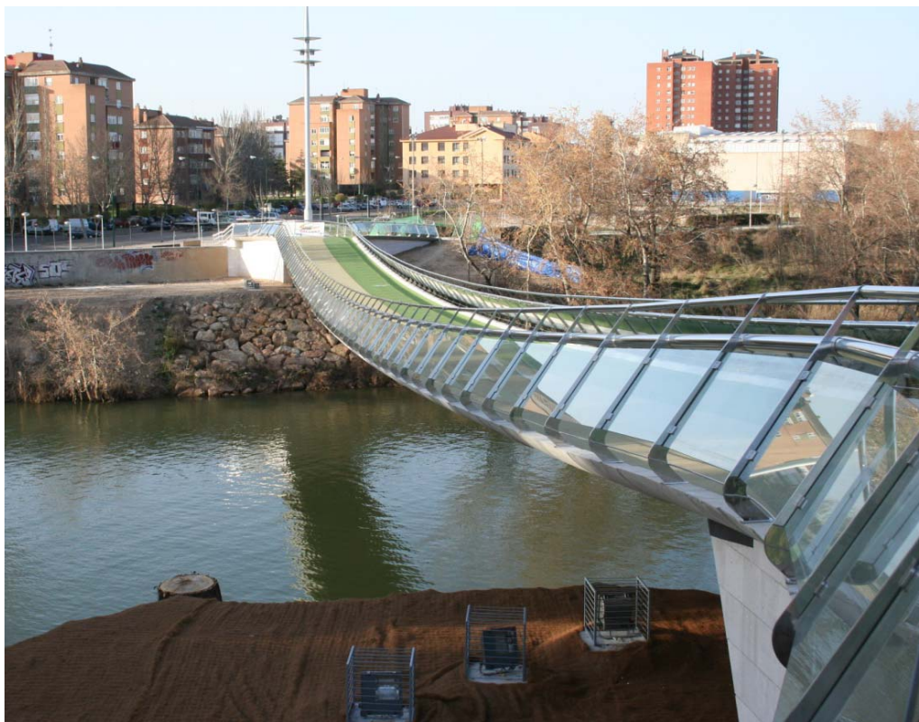
Figura 7. Vista desde aguas abajo.
