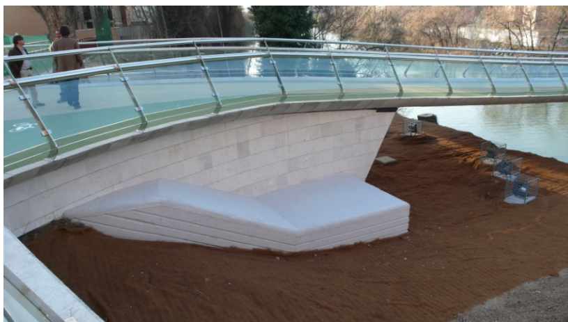
Figura 16. Vista de los estribos
