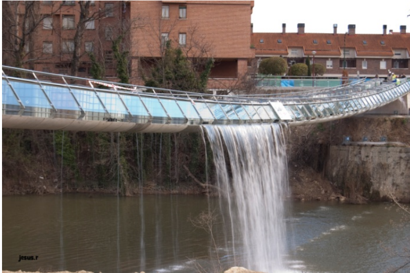
Figura 14. Prueba estática. Cascada sobre el Pisuerga tras el vaciado de los depósitos
