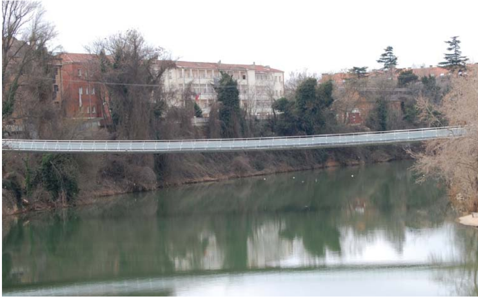
Figura 2. Vista desde el río de la pasarela acabada
