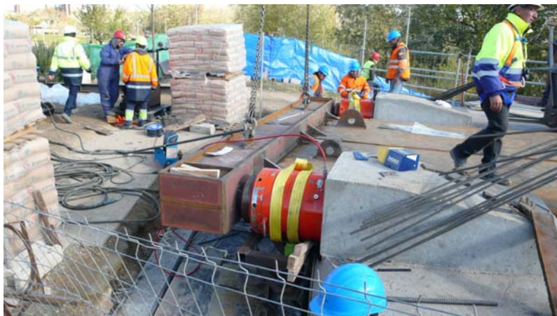
Figura 11. Gatos y viga de reacción para el ajuste de geometría.
