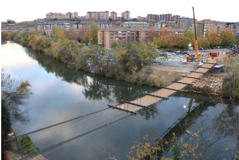
Figura 10. Vista del lanzamiento de la pletina
