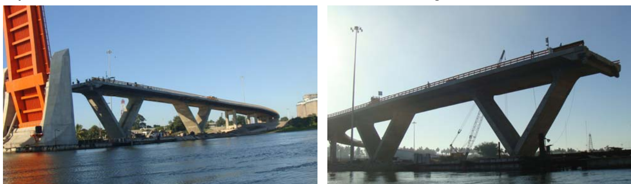
Figura 7. Tramos de hormigón del puente y acceso de margen izquierda
