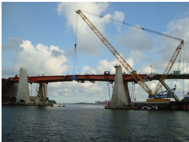
Figura 13. Montaje de la estructura metálica
