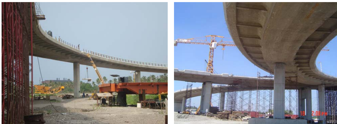
Figura 6. Ramal curvo del viaducto de acceso
