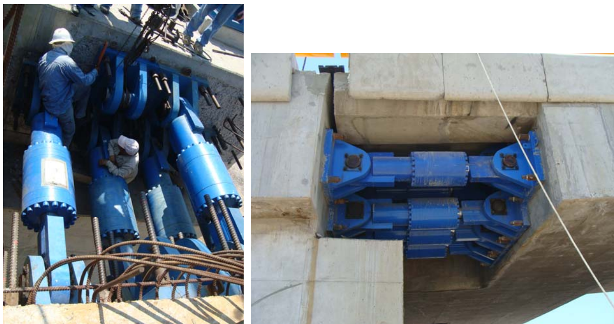
Figura 5. Bloqueadores de choque de los estribos
