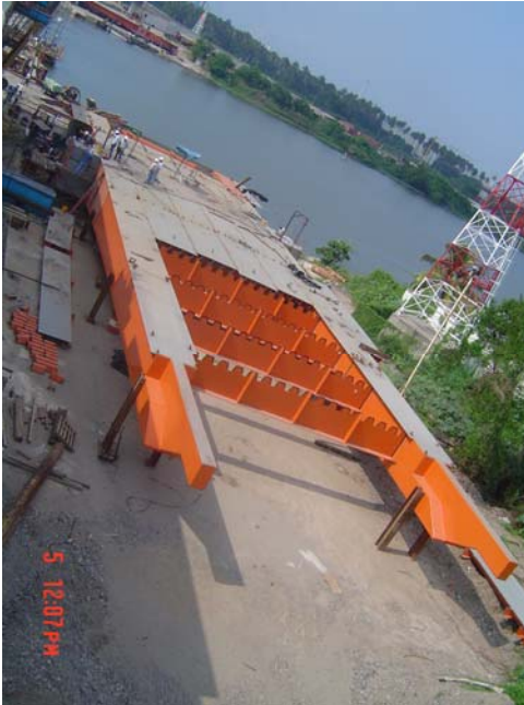
Figura 10a. Tablero del puente móvil en construcción
