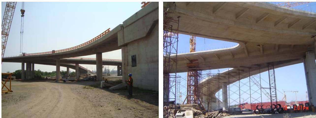
Figura 4. Viaducto de acceso de margen derecha
