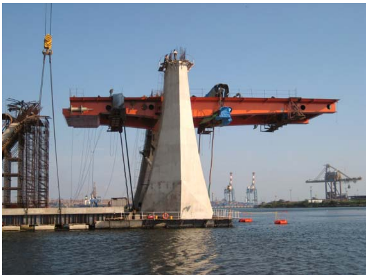
Figura 8. Un tablero del puente basculante con el contrapeso y el pasador de fijación
