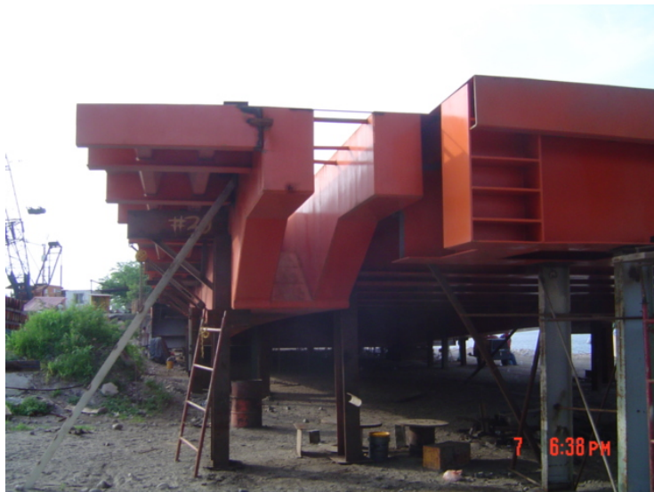
Figura 12. Apoyo en doble ménsula de la clave (ver también figura 10a)
