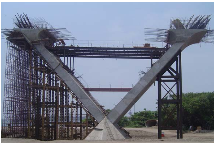
Figura 9. Pila en V durante la construcción
