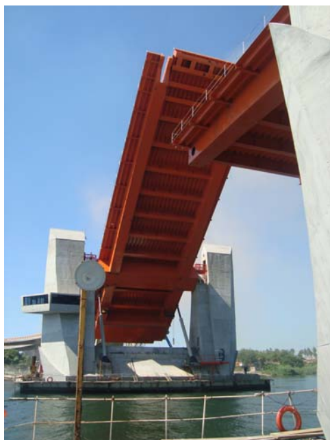
Figura 14. El puente en la operación de apertura
