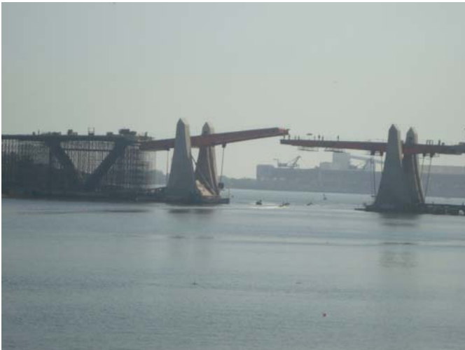
Figura 3. El puente móvil basculante en construcción
