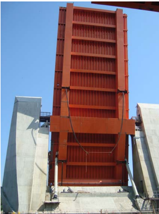
Figura 11. Estructura del tablero del puente móvil
