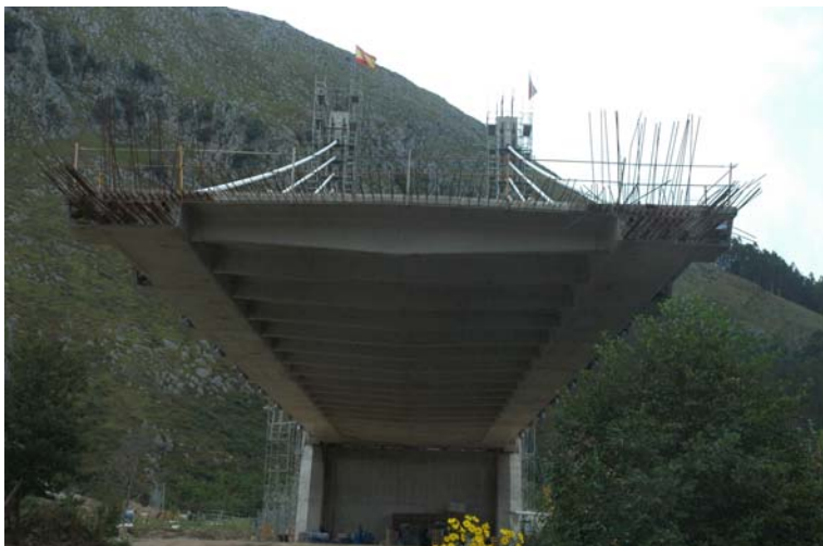
Figura 5. Sección transversal del tablero
