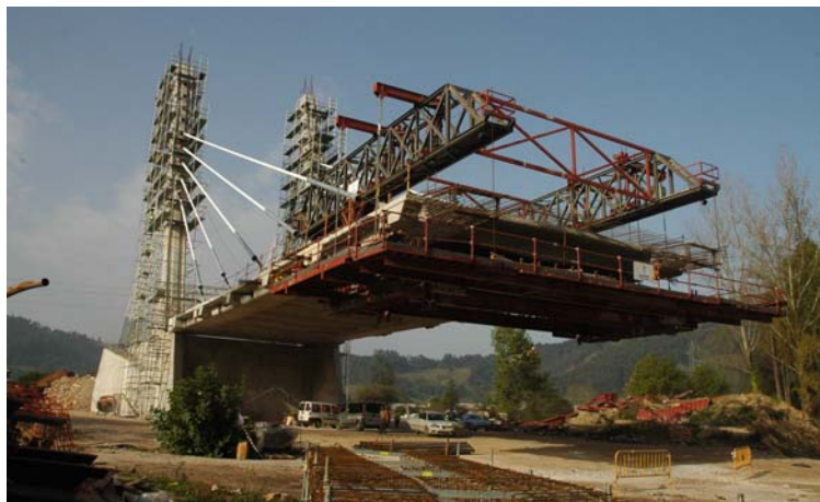
Figura 8. Construcción del voladizo de margen izquierda
