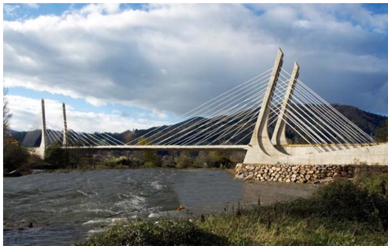
Figura 1. Vista general del puente
