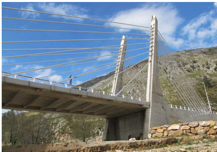
Figura 6. Tablero, torres y tirantes
