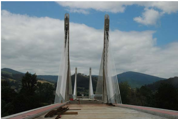
Figura 4. Tirantes del puente
