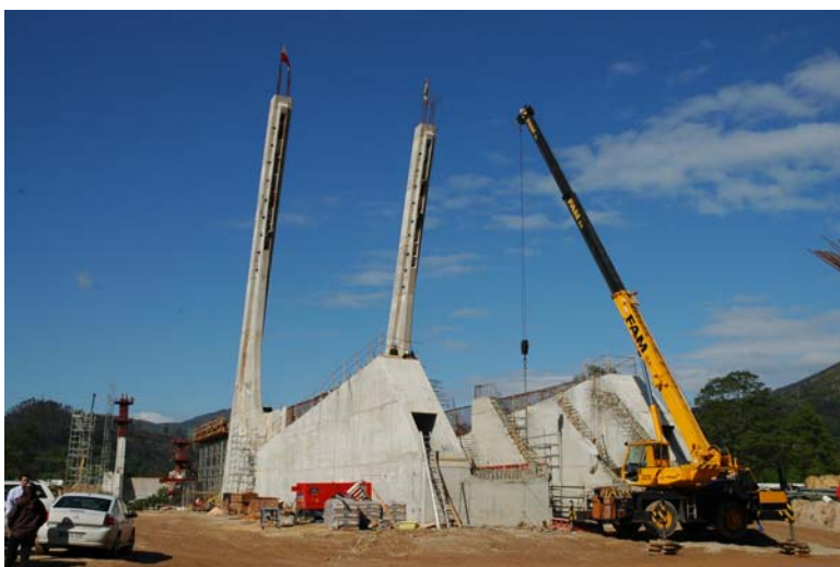
Figura 3. Torres de margen derecha
