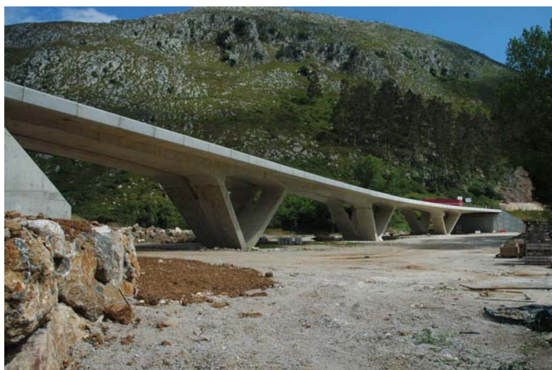
Figura 7. Viaducto de acceso
