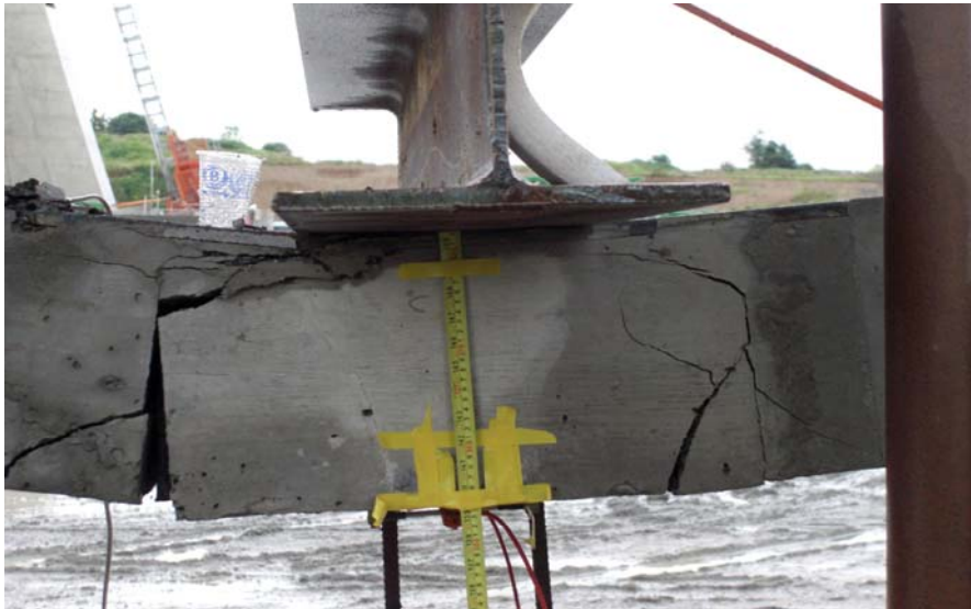
Fig.14. Losas prefabricadas: situación al final del ensayo
