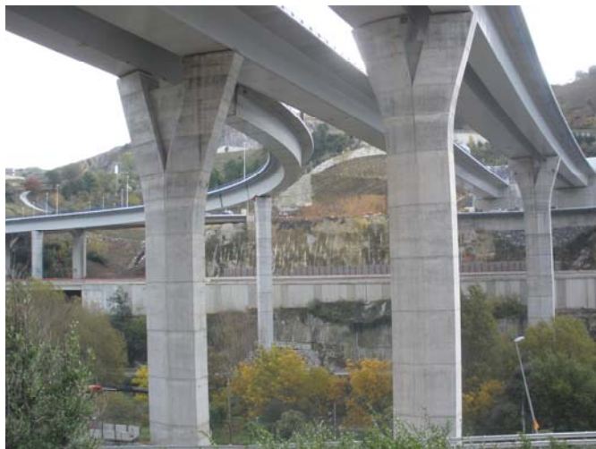
Figura 5. Pilas dobles.
