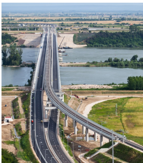
Figura 3. Puente de aproximación del ferrocarril, transición
