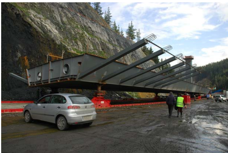
Figura 4. El cajón metálico en el parque de montaje
