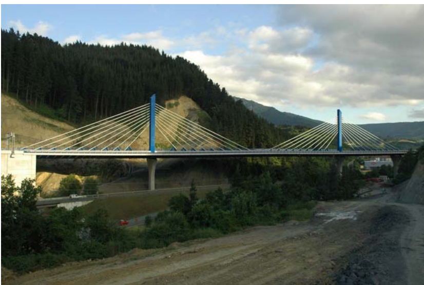
Figura 1. Viaducto de Arbizelai
