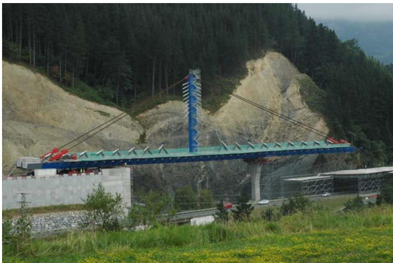
Figura 5. Proceso de empuje del tablero
