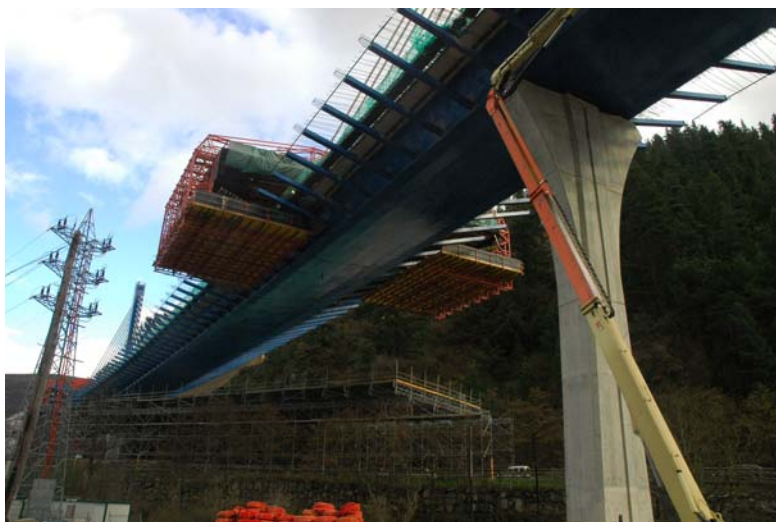
Figura 6. Carros de construcción de los voladizos laterales
