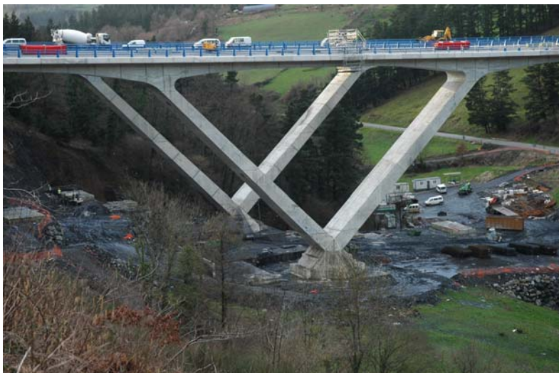
Figura 3. Pilas en V de los viaductos
