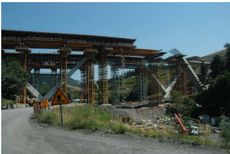
Figura 4. Construcción sobre cimbra
