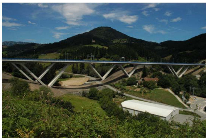
Figura 1. Viaductos de Basagoiti
