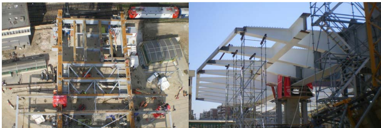
Figura 8. Detalle de vigas en zona de escaleras y voladizos
