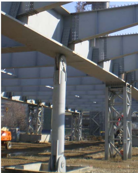
Figura 11. Biela en pila PC1
