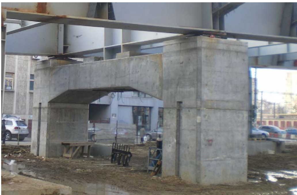
Figura 12. Pórtico de pila PC3
