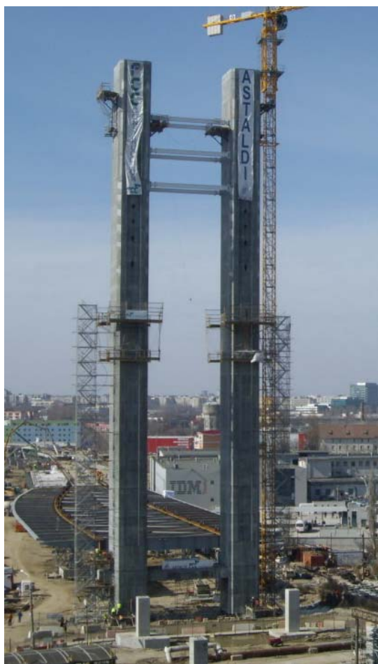
Figura 10. Torre en construcción 2000 T por fuste. Para soportar estas tracciones se aloja una biela metálica dentro de cada fuste hueco de hormigón. Está cimentada sobre 24 pilotes de 1.50 m de diámetro.
