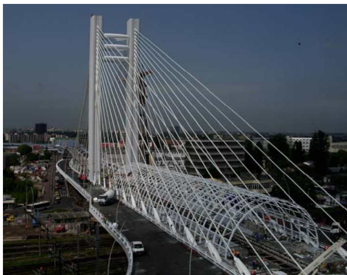
Figura 1. Vista general del puente
