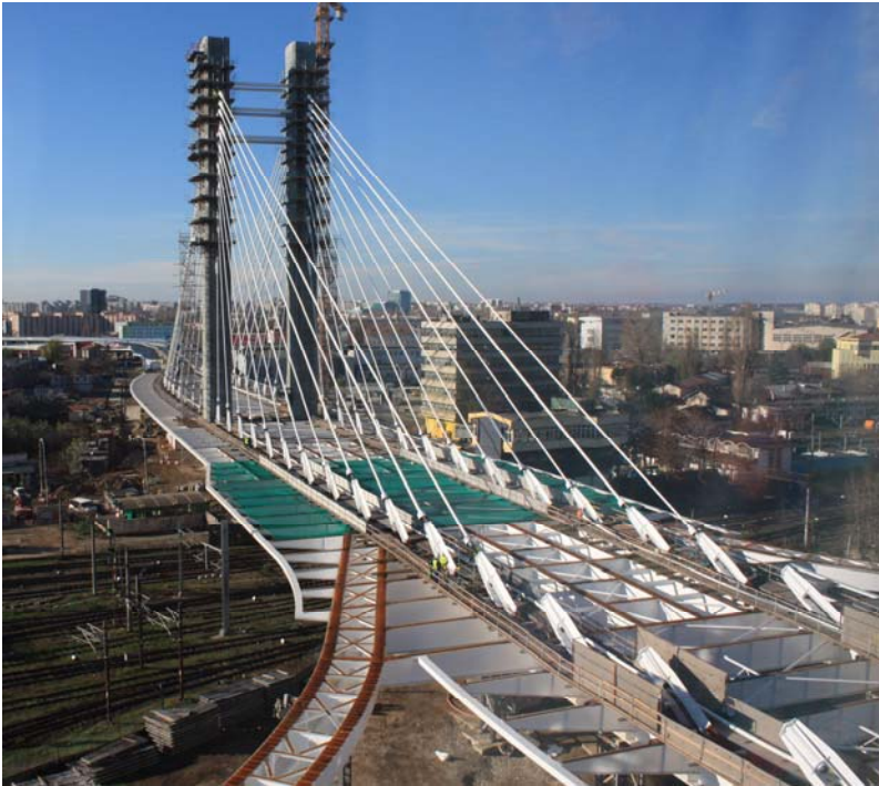
Figura 5. Emparrillado en zona de rampas y escaleras
