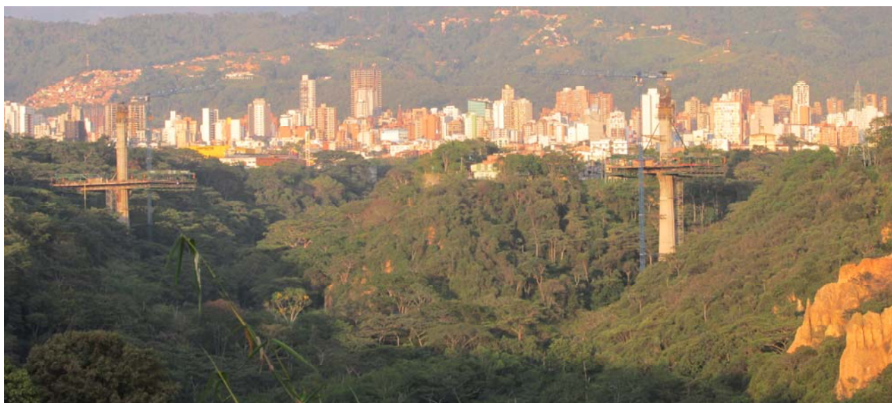
Figura 3. Panorámica del puente en construcción.
