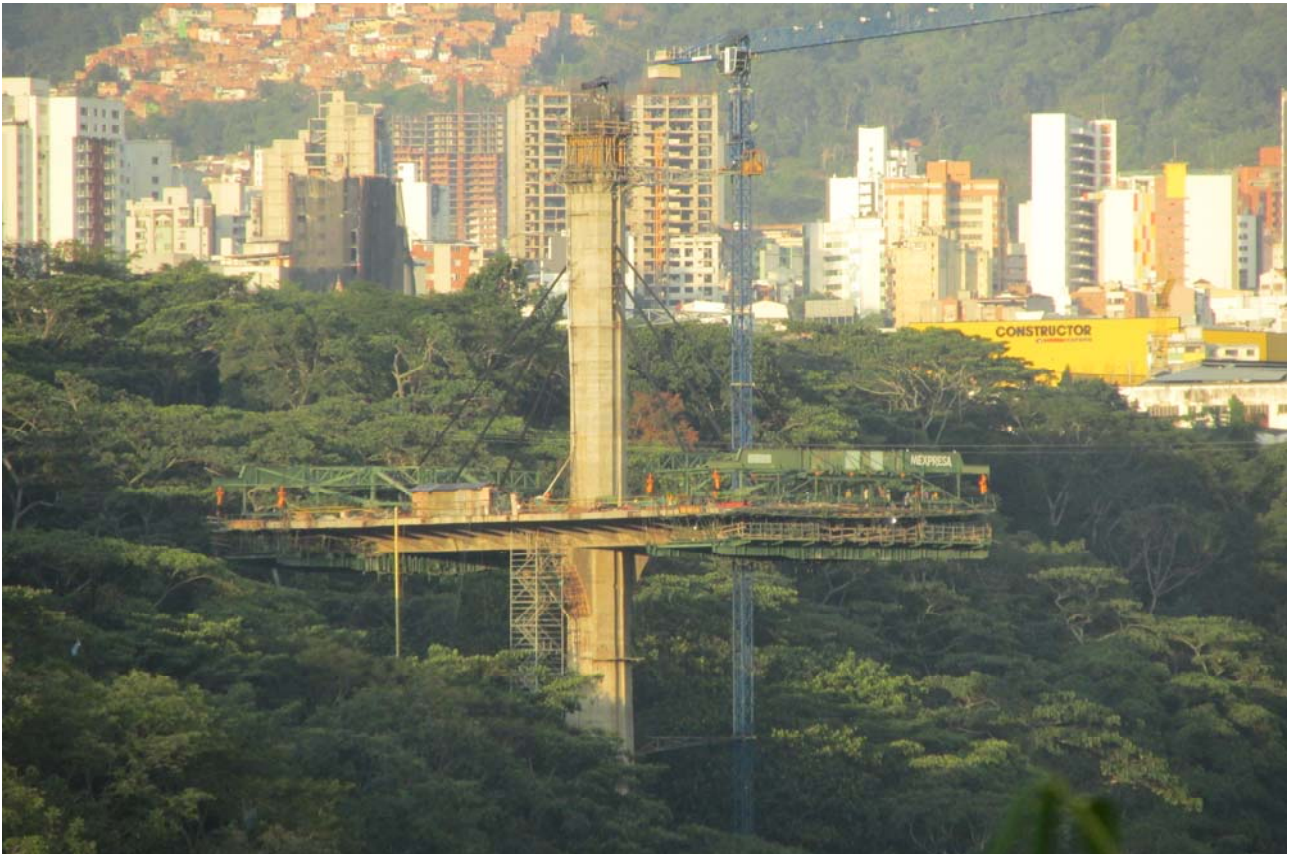
Figura 9. Voladizo en construcción.
