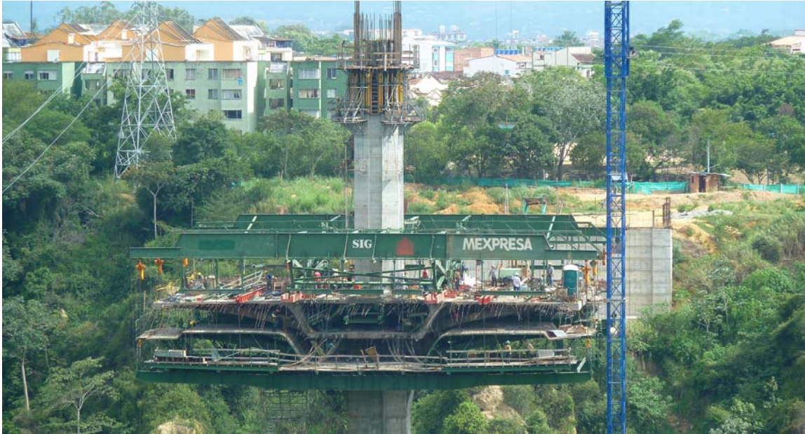
Figura 7. Carro de avance en voladizo.
