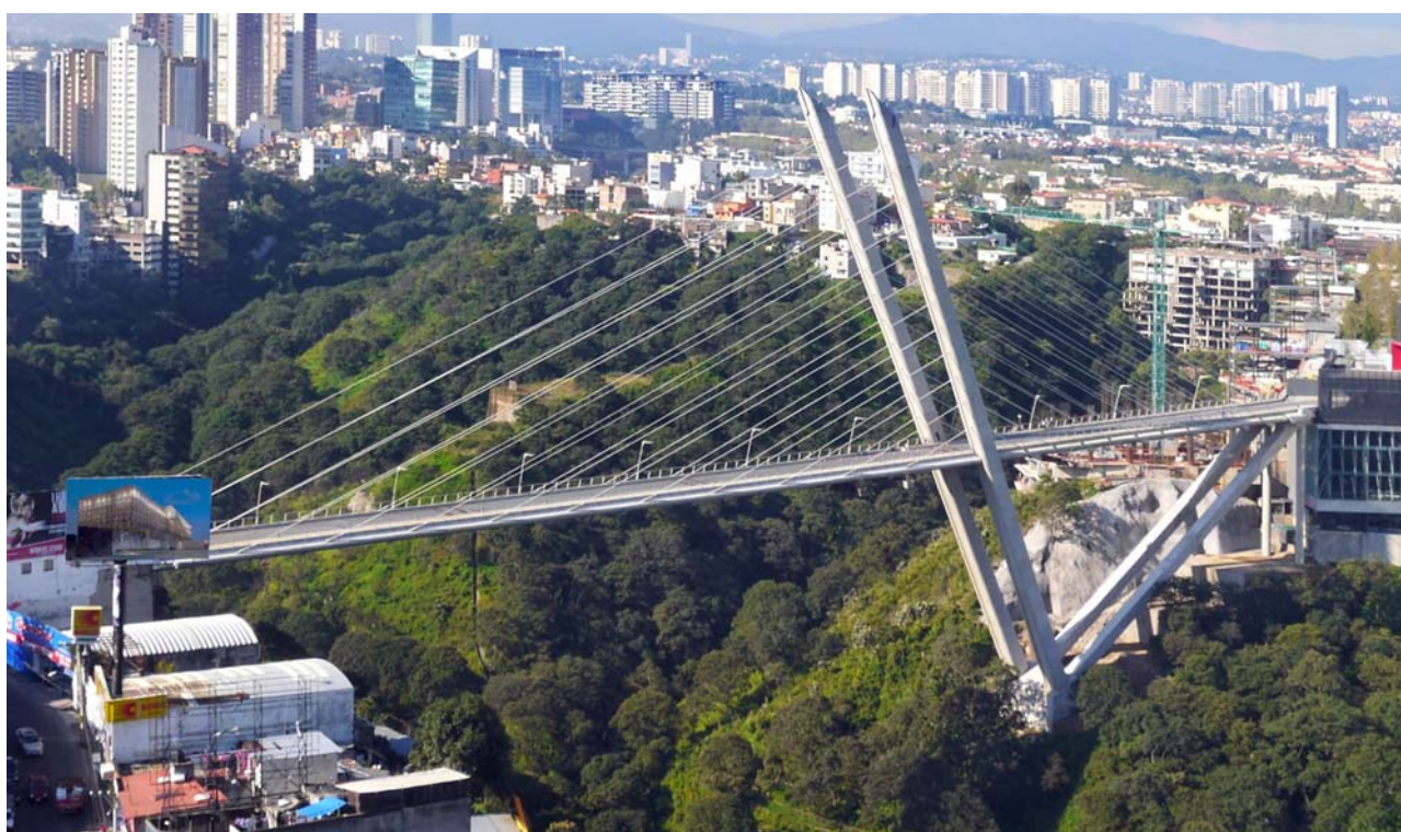
Figura 1. Vista aérea del puente.
