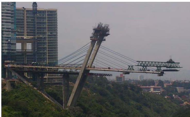
Figura 5. Puente en construcción, dovela metálica.
