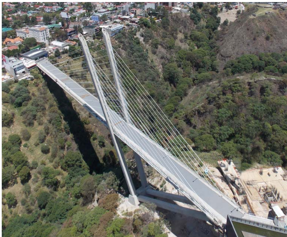
Figura 4. Vista aérea del puente.
