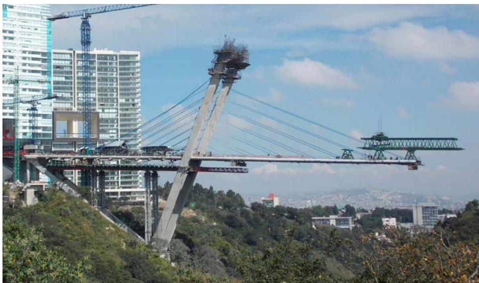
Figura 6. Puente en construcción, carro de avance.
