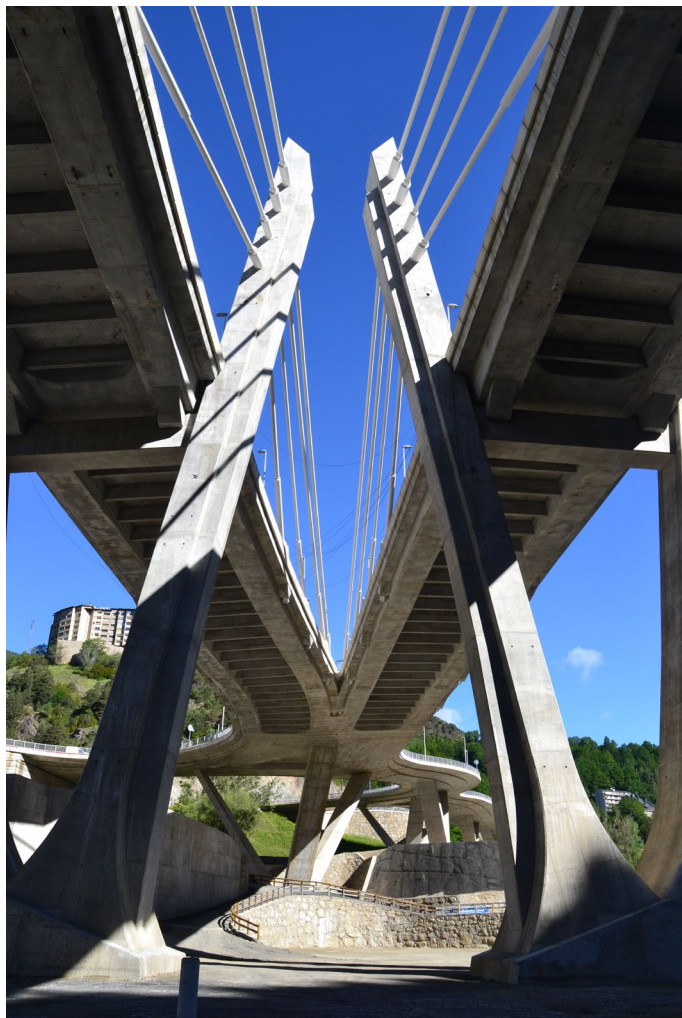
Figura 5. Estructura 1. Vista inferior del puente
