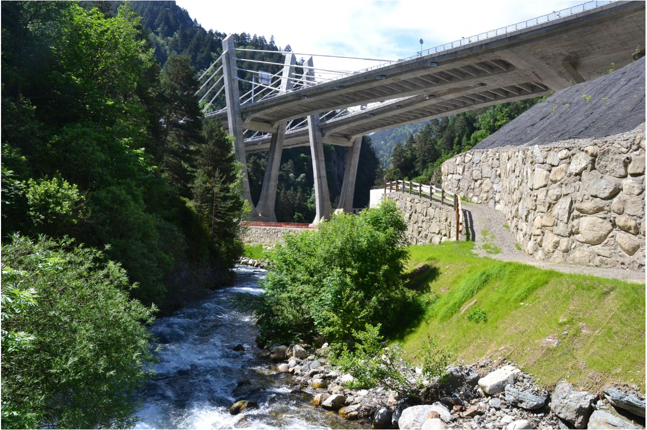
Figura 1. Vista de la estructura 1
