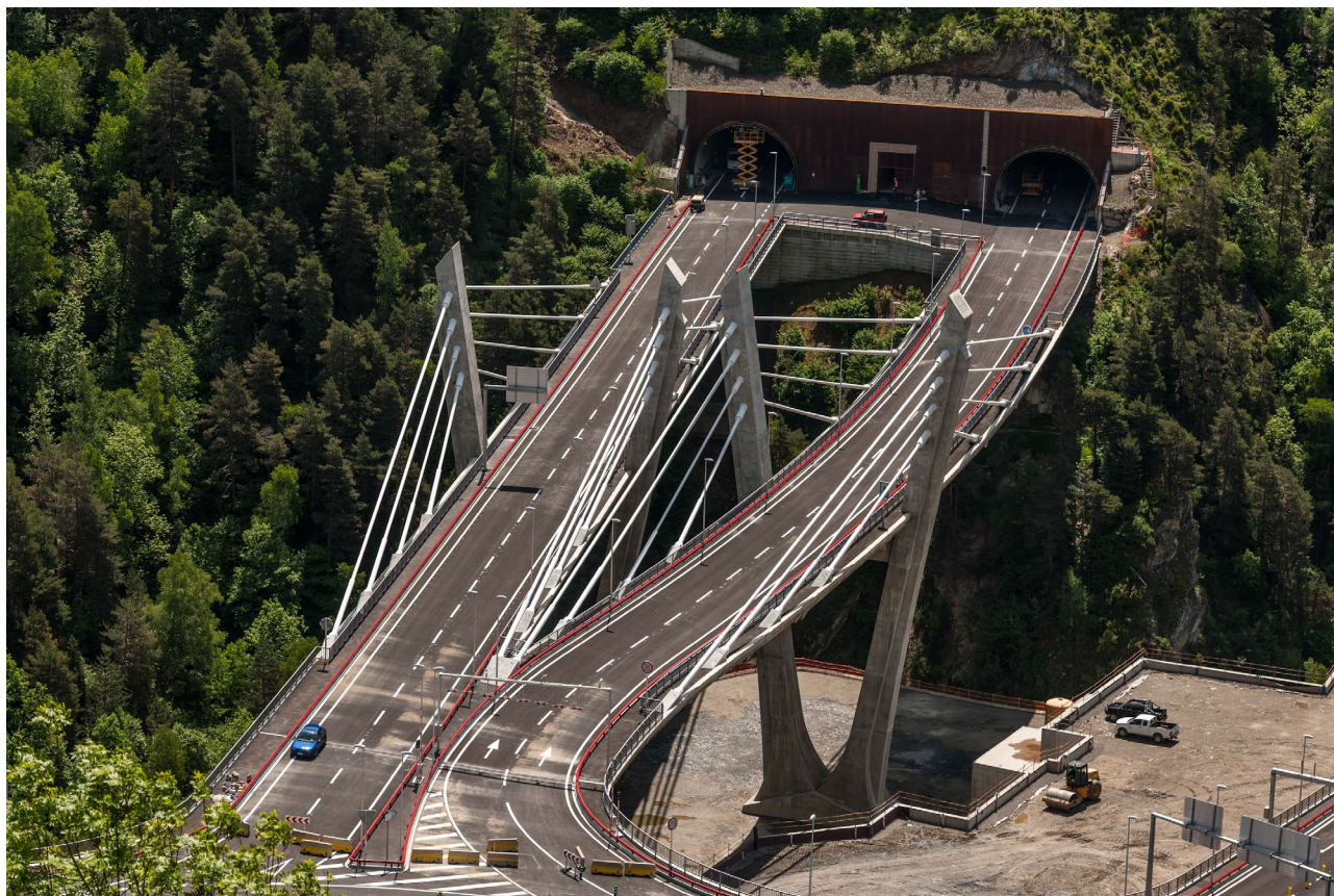
Figura 4. Vista de la estructura 1
