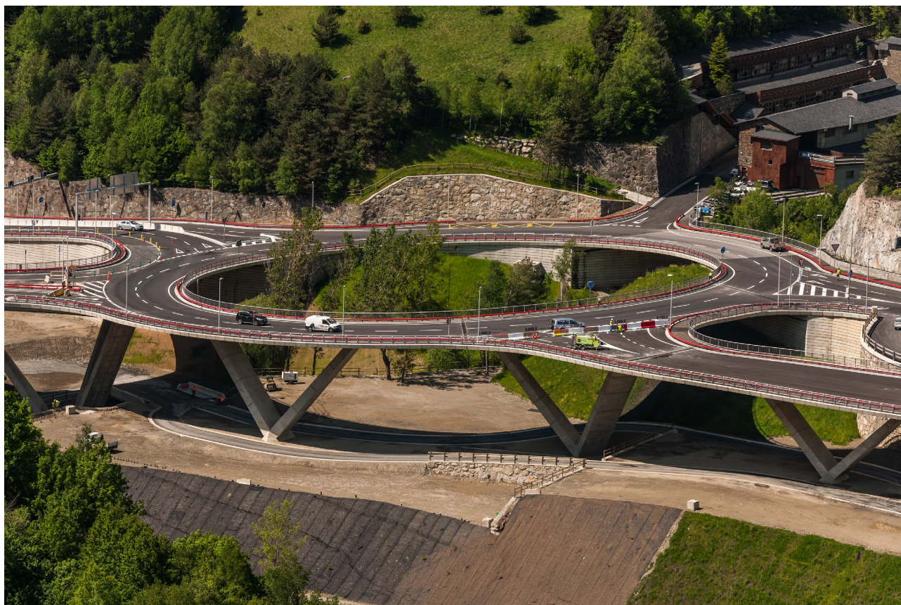
Figura 2. Vista de la rotonda
