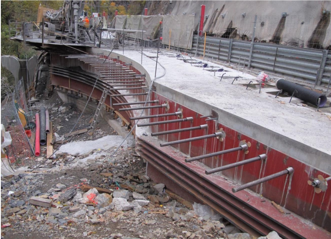
Figura 4. Vista de la viga con la chapa y barras donde se conecta la estructura
