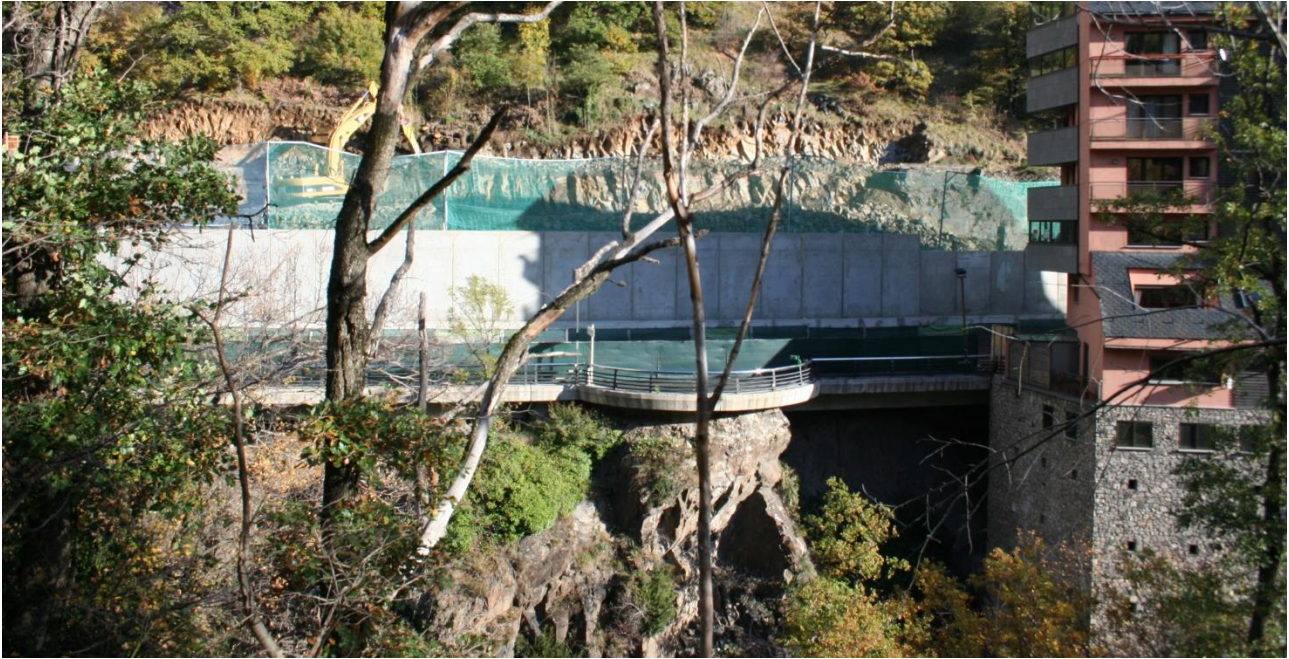
Figura 1. Situación previa a la obra
