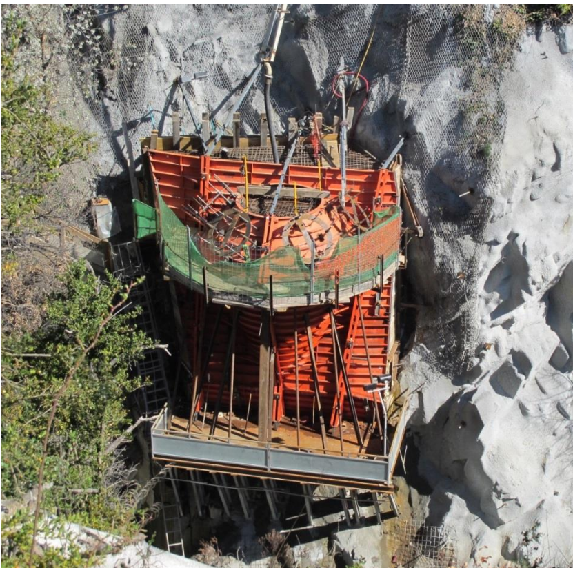
Figura 5. Vista del encofrado del macizo de hormigón
