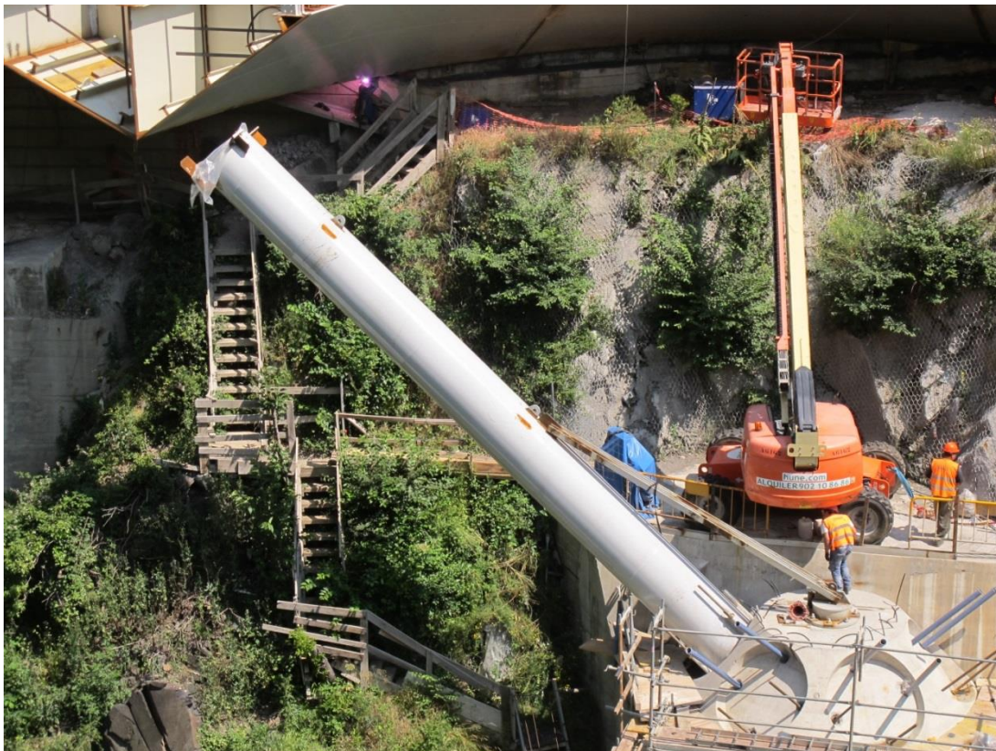
Figura 10. Montaje de una de las pilas
