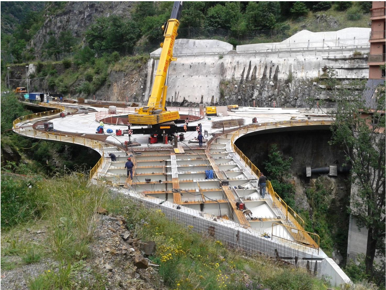
Figura 11. Imagen de la estructura ya apoyada en el estribo 2 y con la zona exterior montada
