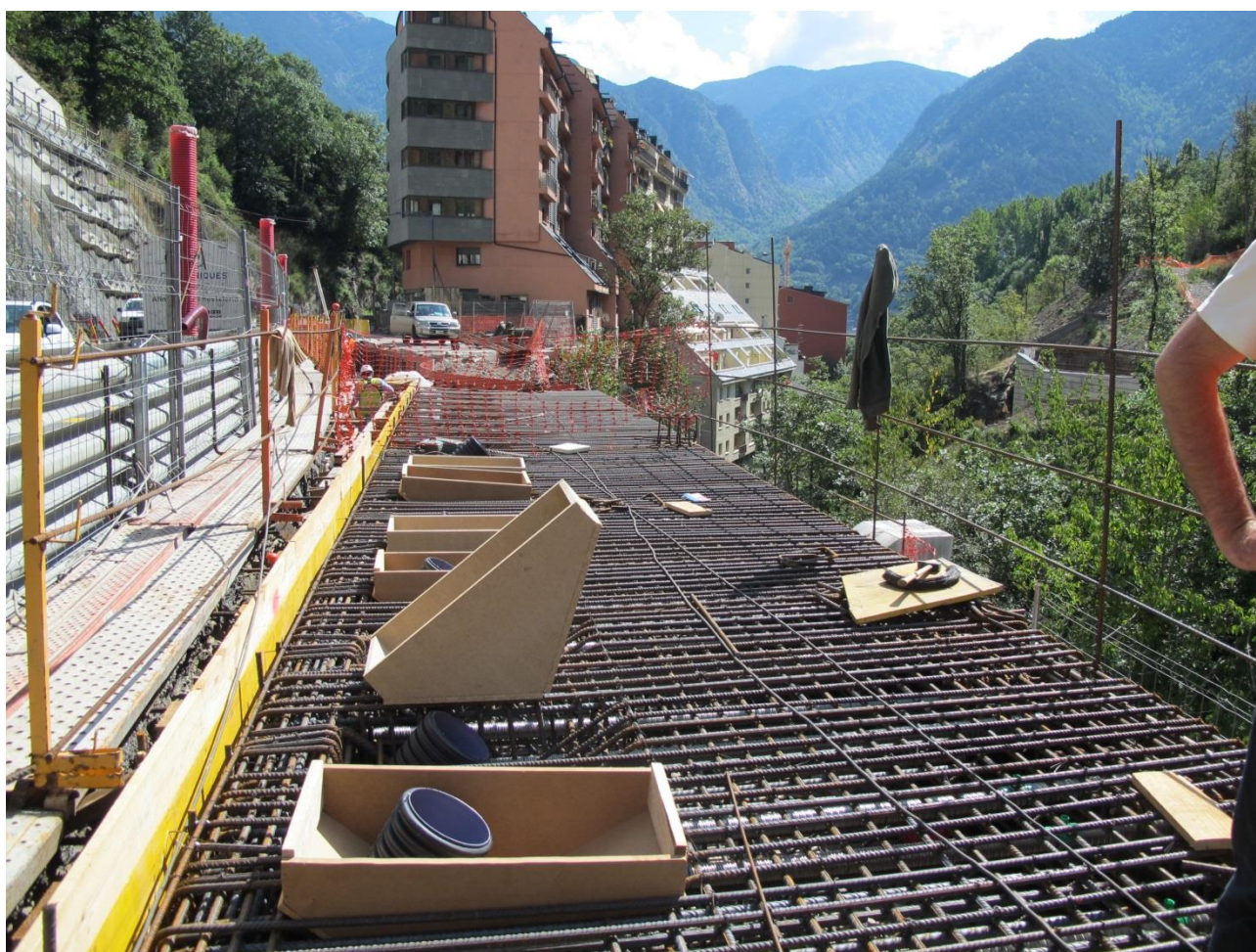
Figura 3. Vista de la viga y las reservas de los anclajes antes del hormigonado
