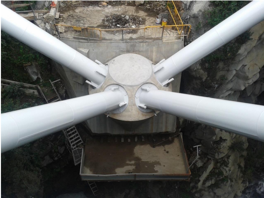
Figura 6. Vista del macizo con los pilares
