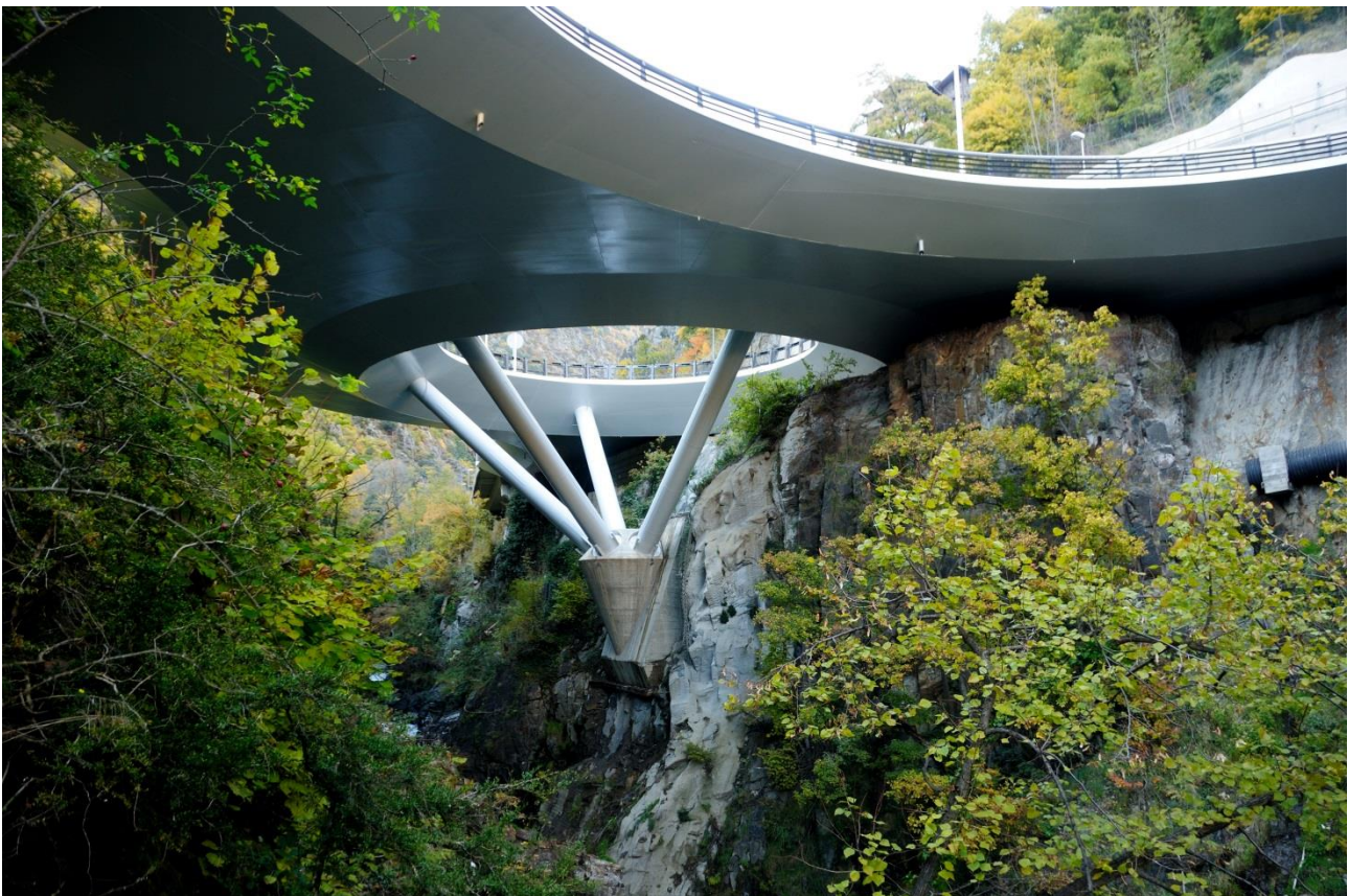
Figura 2. Vista de la estructura
