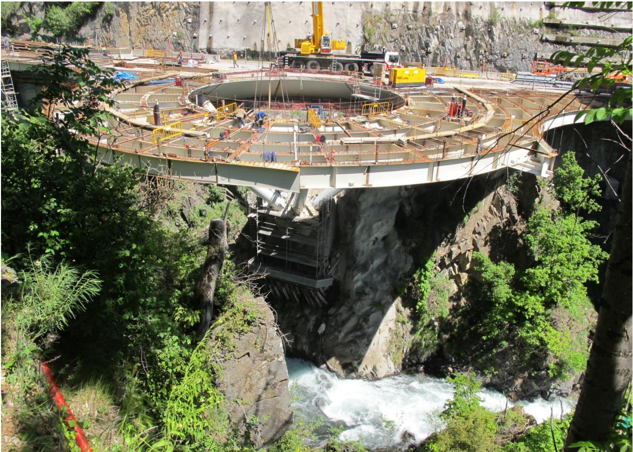
Figura 8. Vista del interior del tablero durante la construcción
