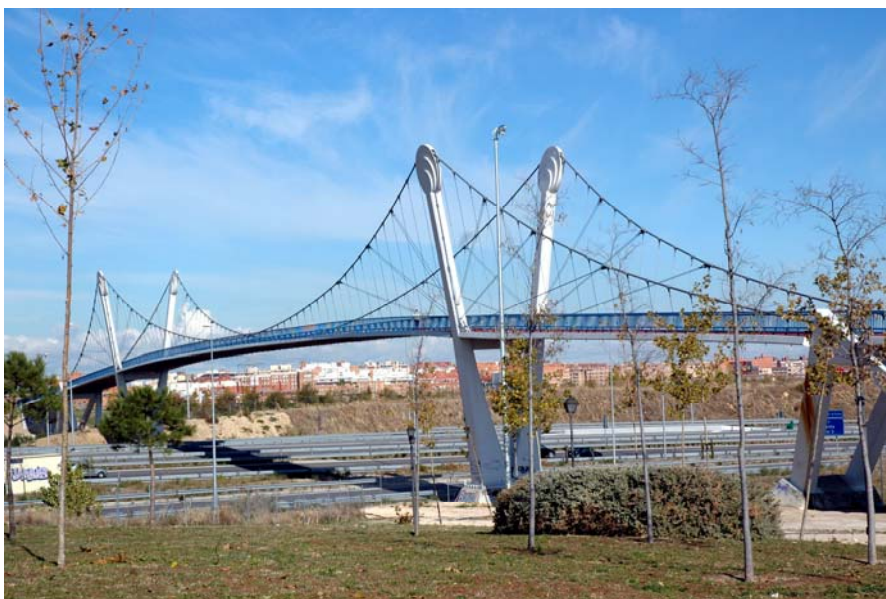
Fig. 3 Pasarela sobre la R-3
