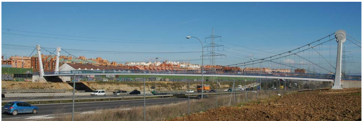
Fig. 15 Pasarela sobre la M-40
