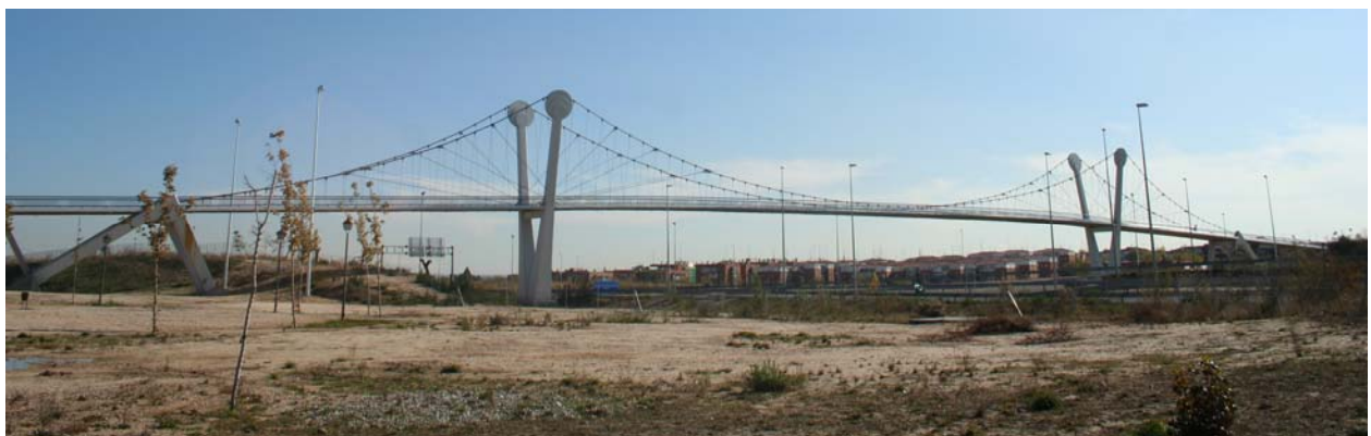
Fig. 16 Pasarela sobre la R-3
