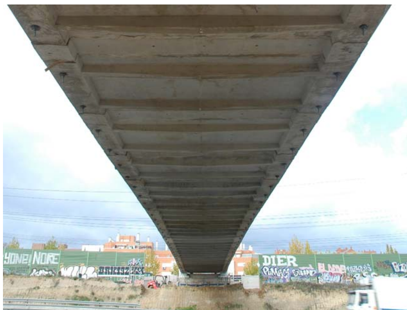
Fig. 9 Vista inferior del tablero
