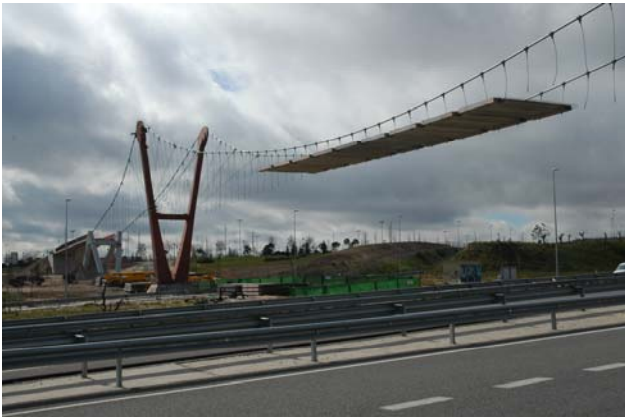
Fig. 14 Pasarela sobre la R-3 en construcción
