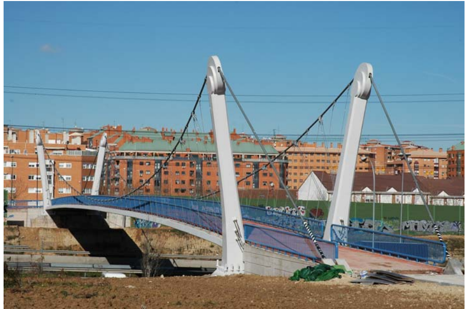
Fig. 2 Pasarela sobre la M-40
