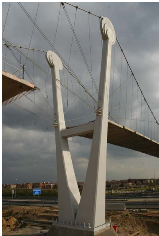
Fig. 11 Torre de la Pasarela sobre la R-3
