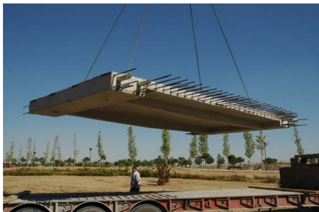
Fig. 8 Dovelas prefabricadas del tablero
