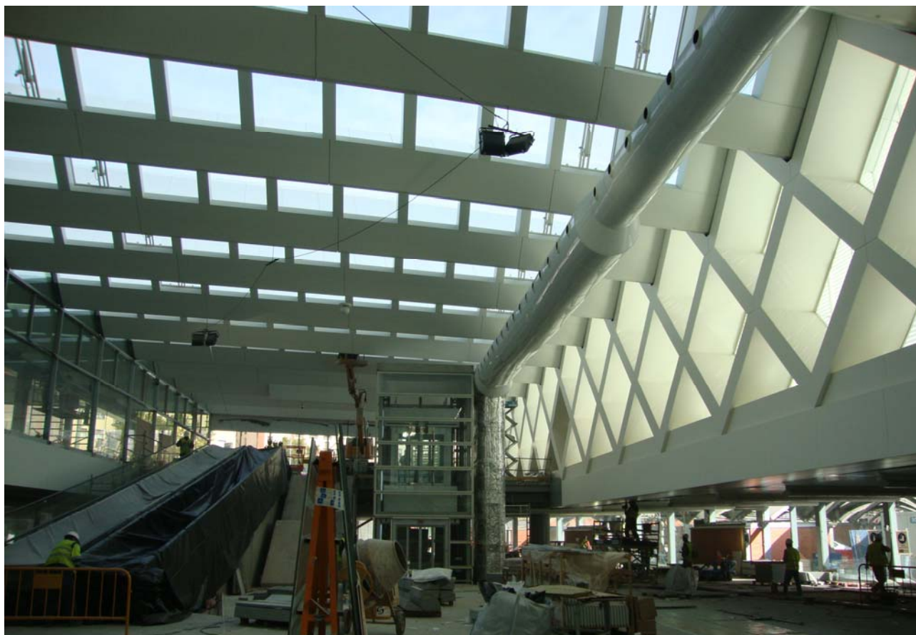
Figura 8. Vista interior del vestíbulo de llegadas
