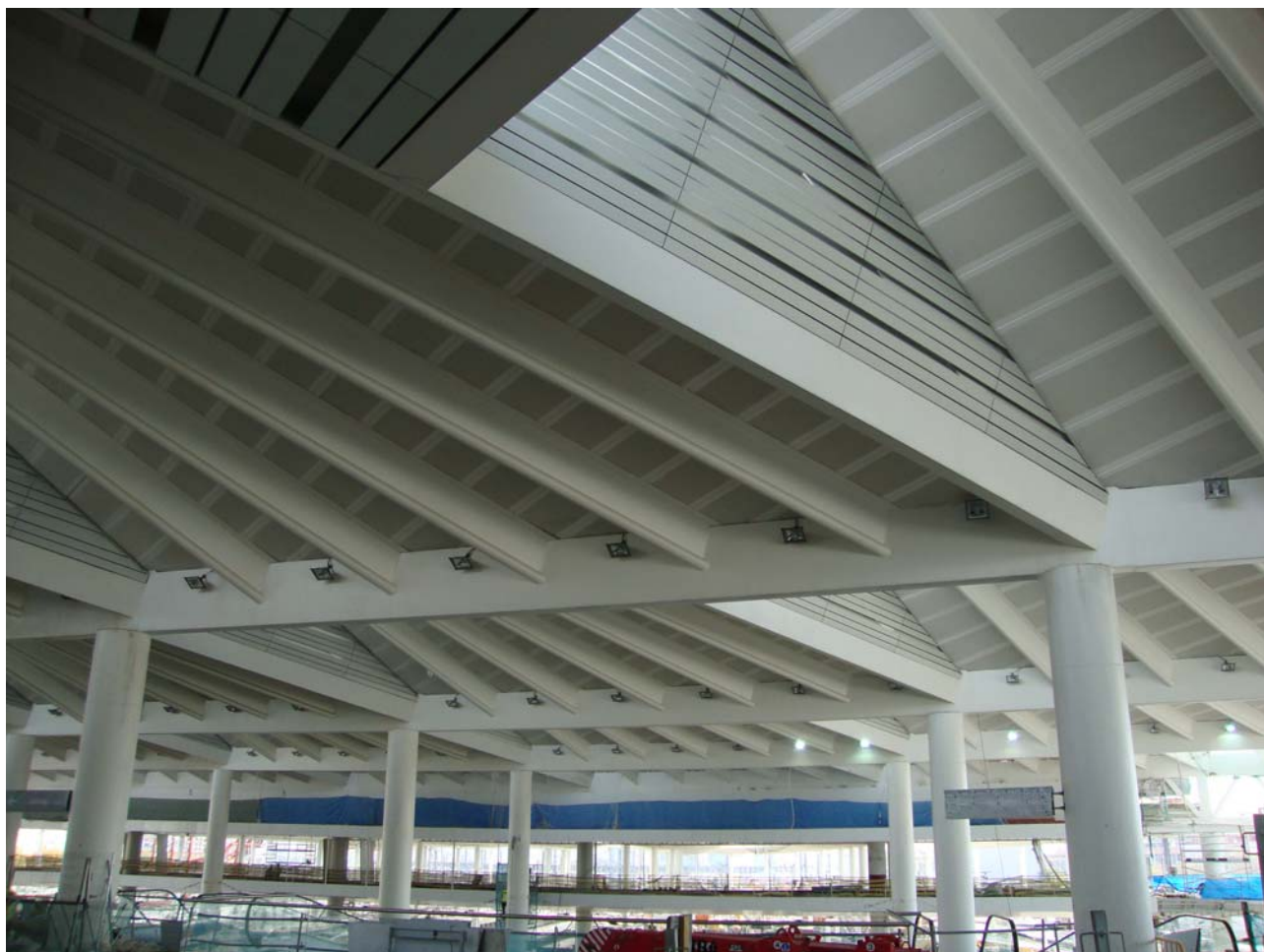
Figura 1. Vista general de la cubierta alta
