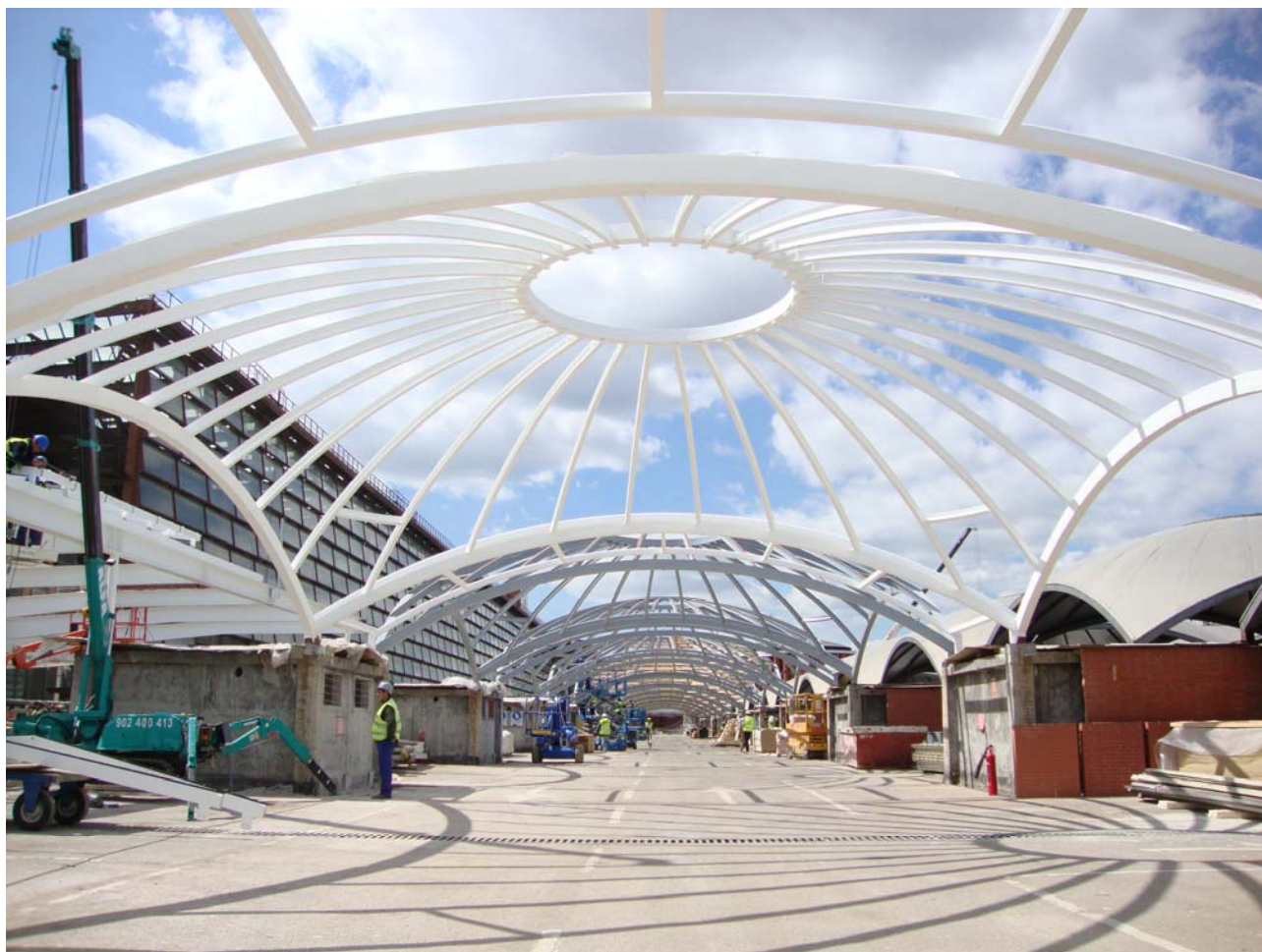
Figura 6. Estructura de las cúpulas del pasillo rodante
