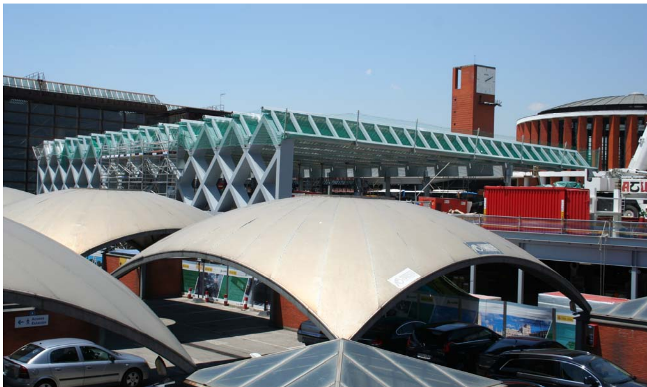
Figura 7. Vista general del vestíbulo de llegadas
