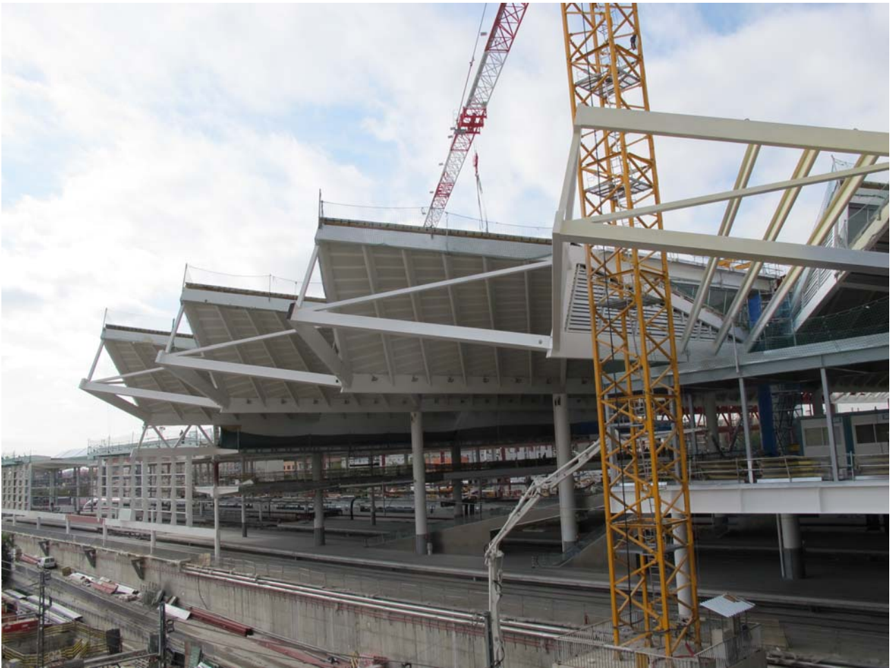
Figura 2. Vista del tramo en voladizo en la zona este junto a Cercanías
