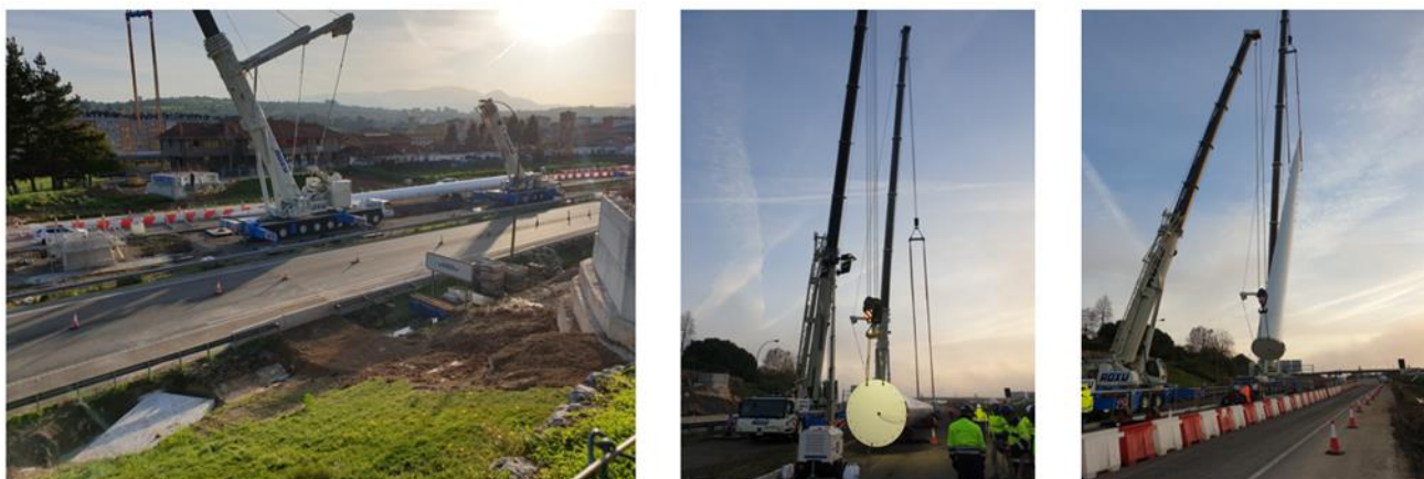
Figura 8. Diferentes etapas de izado del pilono.
