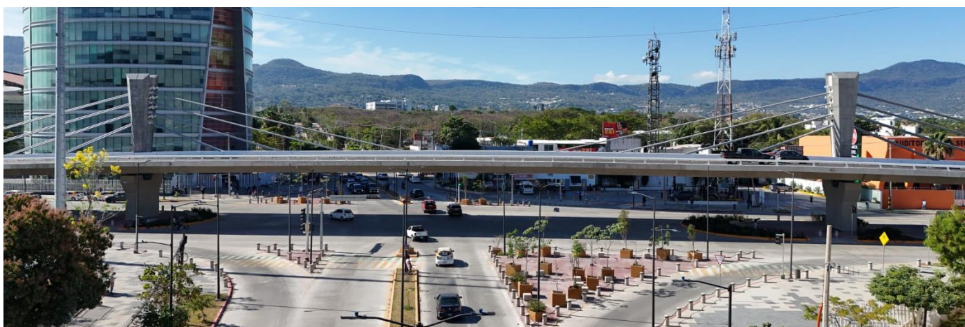
Figura 9. Zona central del viaducto terminado
