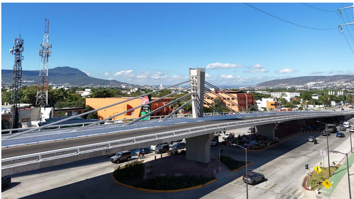
Figura 4. Torre y vista general del viaducto
