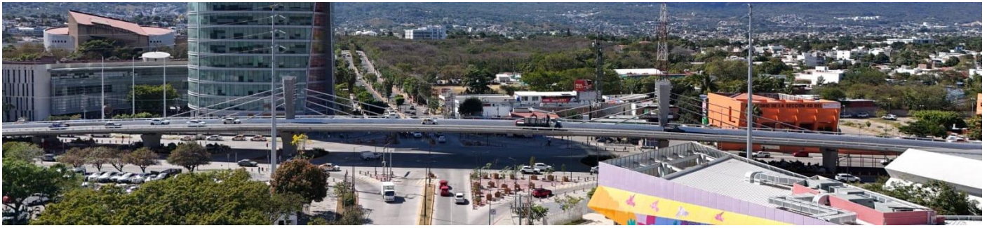
Figura 1. Vista general del viaducto
